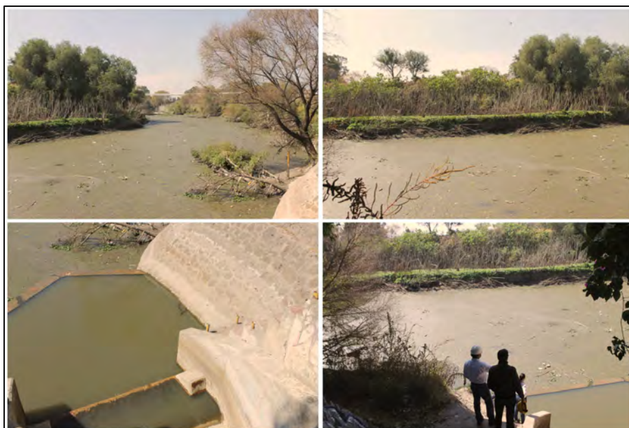
Foto 2. Vista general del Río Lerma a la altura del punto de descarga de la CT Salamanca
