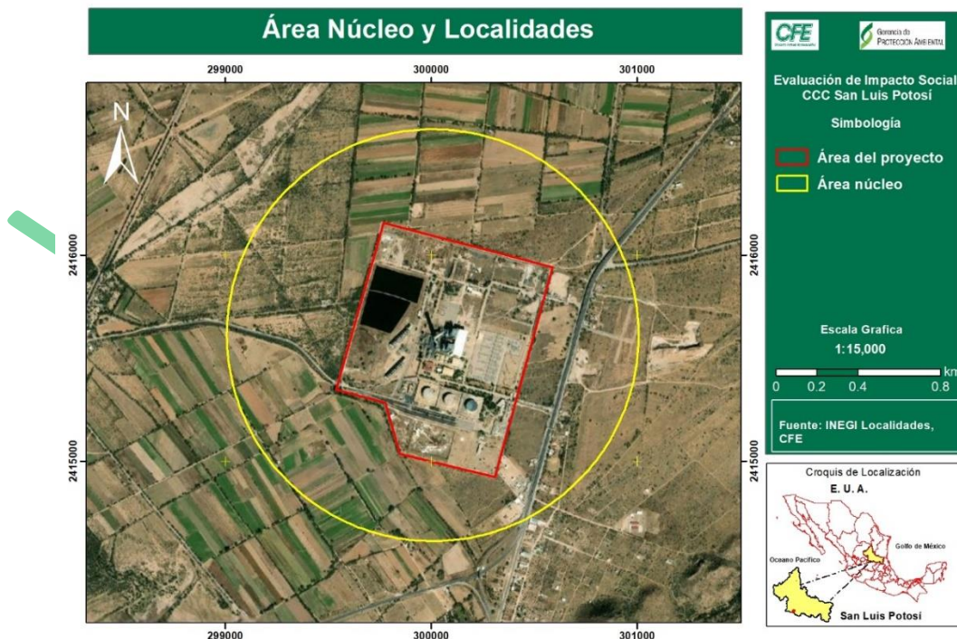
Ilustración III.1. Localidades del Área Núcleo del proyecto CCC San Luis Potosí
