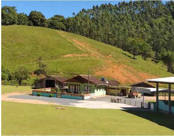
Foto 10.3-58: Unidade habitacional localizada no Bairro Arraial do Ouro, Município Gaspar.
