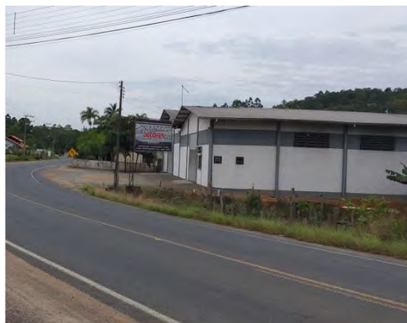
Foto 10.3-71: Infraestrutura existente no bairro Rodeio 12, município de Rodeio.
