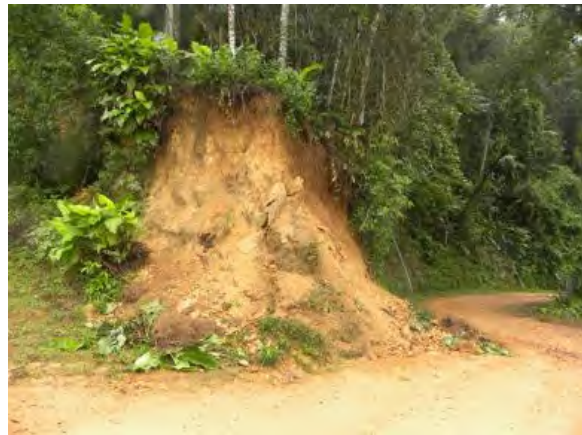
Foto 5.3-82: Detalhe de talude de corte com sinais de instabilização na porção superficial, envolvendo pequeno volume de cambissolo presente no local (cerca de 0,5 m³), decorrente da saturação do material e perda de suporte da porção basal, associado à verticalidade do talude na via de acesso, registrado na região de rio Natal, município de São Bento do Sul/SC. Coord.: 22 J 667203 m E 7084628 m S.
