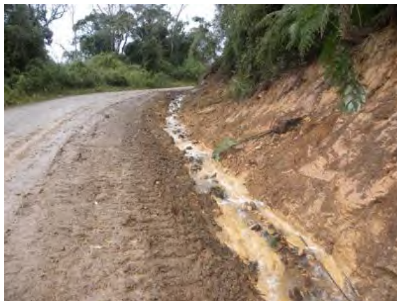
Foto 5.3-83: Caracterização do acúmulo de água na lateral da via de acesso, que, aliada a uma declividade acentuada do terreno, favorece ao processo erosivo sobre rochas areníticas da Formação Botucatu. Na época da fotografia a via passava por uma manutenção, com recuperação do piso e do talude. Registro no acesso a Colônia Santa Helena no município de União da Vitória/PR. Coord.: 22 J 507138 m E 7129776 m S.
