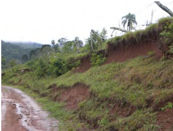
Foto 5.3-86: Detalhe de escorregamento envolvendo um volume de material heterogêneo, onde aparece mobilizado neossolo e rocha basáltica alterada, exposto em talude de corte subvertical ao longo de via de acesso local, na região de Pinhalzinho, município de Cruz Machado/SC. Coord.: 22 J 459010 m E 7132133 m S.
