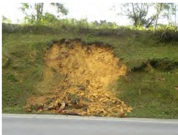
Foto 5.3-72: Detalhe de cicatriz e massa acumulada no pé do escorregamento, envolvendo volume da ordem de 2 m³ de material saprolítico mobilizado de talude de corte subvertical junto a rodovia BR-280. Instabilidade típica deste padrão de relevo, conforme observado na região do Rio Preto Velho, município de Mafra/SC. Coord.: 22 J 637394 m E 7095208 m S.
