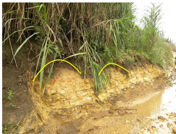
Foto 5.3-75: Detalhe de cicatrizes de pequenos escorregamentos envolvendo camada superficial de nitossolo sobreposto a rocha pelítica saprolitizada, num corte de terreno de pequena dimensão, observado no acesso a localidade de São João, na região de Tigre, município de Três Barras/SC. Coord.: 22 J 575310 m E 7111064 m S.
