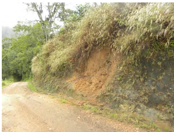
Foto 5.3-69: Detalhe de escorregamento de rocha saprolítica, envolvendo um volume relativamente pequeno de material, instabilizado pelo acúmulo de água no talude e cuja verticalidade do corte, favoreceu o rompimento do material na região de rio Natal, próximo a cachoeira do Kohler, município de São Bento do Sul/SC. Coord.: 22 J 670760 m E 7084658 m S.
