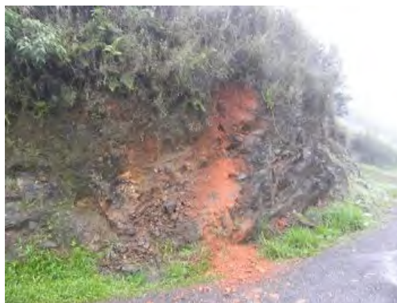
Foto 5.3-78: Detalhe de pequeno escorregamento mobilizando solo no contato solo/rocha saprolítica, presente em talude de corte vertical. A saturação do material superficial e o descalçamento da base de apoio deste material (em função do corte) favoreceram o surgimento do processo. Registro evidenciado em talude junto à BR-280, na região da Fazenda Três Irmãos, município de São Bento do Sul/SC. Coord.: 22 J 660864 m E 7087643 m S.
