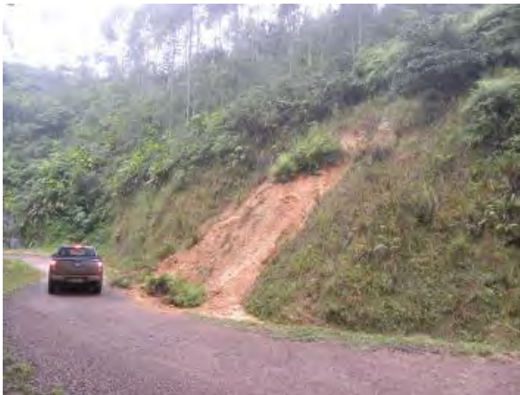
Foto 5.3-81: Detalhe de escorregamento de solo e material saprolítico, envolvendo um volume da ordem de 30 m³ correlacionado a instabilização de um maciço, em função de corte subvertical, na Serra de Corupano, entorno da via de acesso na região de rio Natal, município de São Bento do Sul/SC. Coord.: 22 J 665676 m E 7084454 m S.
