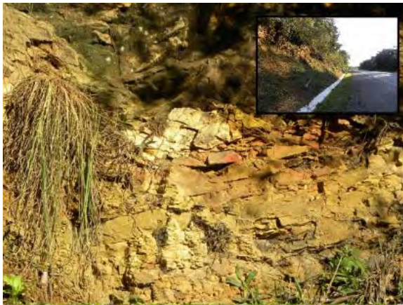
Foto 5.3-11: Siltito bastante saprolitizado, de coloração predominante róseo-amarelada, apresentando estratos centimétricos (variando de 2 a 10 cm) paralelos, com intercalações de laminações delgadas de arenito de granulação fina (muito fina) correlacionados aos litótipos da Formação Taciba, observados ao longo de talude nas margens da BR 280 (ver detalhe), próximo ao acesso a Vila Neumann, na porção leste do município de Mafra/SC. Coord.: 22 J 627661 m E 7100093 m S.
