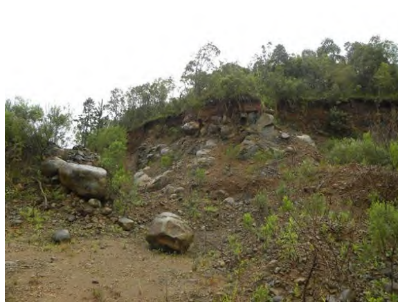
Foto 5.3-85: Blocos e matacões subarredondados, derivados da alteração de rochas basálticas, recobertas por pequena camada de nitossolo, instabilizadas em função do corte executado no terreno; condição que prejudica a escavação e a execução de serviços no local, região de Pinhalzinho, município de Pinhão/PR. Coord.: 22 J 456965 m E 7137861 m S.
