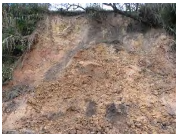
Foto 5.3-73: Caracterização de escorregamento em talude de corte, mobilizando volume de cambissolo háplico, posicionado sobre rochas pelíticas da Formação Taciba Indiviso, com volume da ordem de 6 m³, conforme observado em talude de corte subvertical na região de Boa Vista, município de Rio Negrinho/SC. Coord.: 22 J 640238 m E 7094408 m S.
