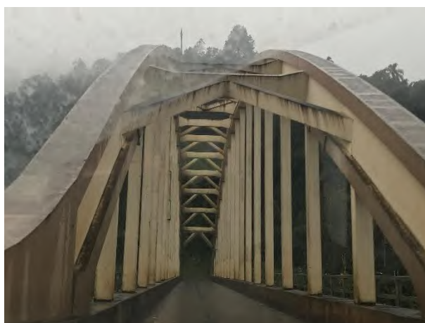
Foto 5.5.3-42 Ponte Manoel Ribas. União da Vitória (PR).
