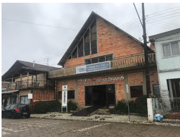
Foto 5.5.3-35: Terminal rodoviário. Rio Negrinho (SC).
