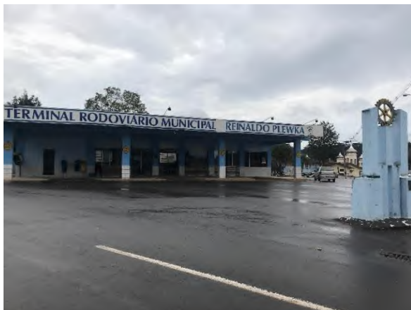
Foto 5.5.3-33: Terminal rodoviário. Cruz Machado (PR)
