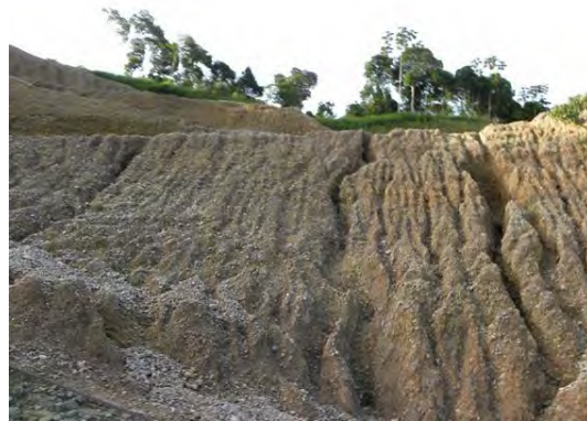
Foto 10.1-56: Caracterização de erosões lineares ao longo da inclinação do talude de corte, sobre paraconglomerados, com presença de sulcos com cerca de 40 cm de profundidade, observado em área de empréstimo no bairro Bela Vista, município de Gaspar/SC. Coord.: 22 J 698255 m E 7023833 m S.
