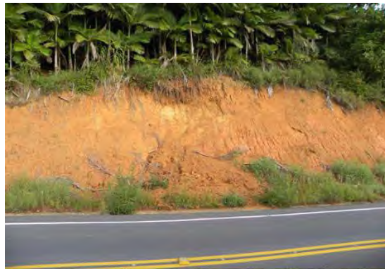
Foto 10.1-19: Detalhe de argissolo vermelho-amarelo, definido em talude de corte, onde se observa um horizonte superficial de tonalidade mais acentuada, sobreposto a um horizonte B argiloso. A condição do corte expõe o solo a processos de instabilização, observado em afloramento às margens da estrada Alto Serafim, na região denominada Belchior Alto, município de Gaspar/SC. Coord.: 22 J 698250 m E 7034545 m S.
