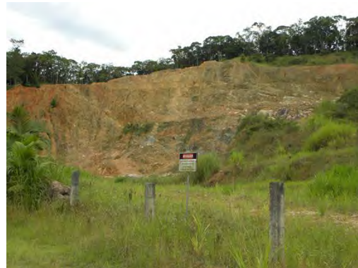
Foto 10.1-3: Talude de corte em área de exploração de saibro, saprólito derivado de rocha tonalítica; presente no vale do “Ribeirão Vale do Selke”, município de Pomerode/SC. Coord.: 22 J 685361 m E 7035420 m S.
