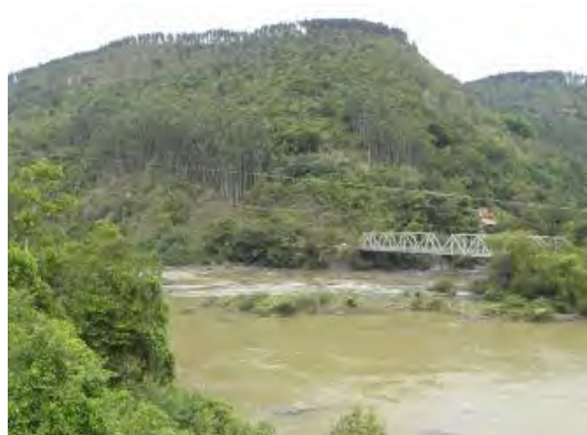
Foto 10.1-37: Detalhe da formação serrana, associada a rochas cristalinas que mostram uma morfologia bastante acidentada, cujas encostas alcançam declividades acima de 50%, observado da BR 470 na confluência entre os rios Itajaí-Açu e Itajaí do Norte, Ibirama/SC. Coord.: 22 J 649151 m E 7004106 m S.
