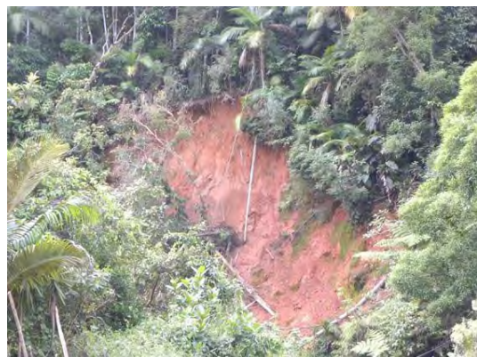
Foto 10.1-58: Cicatriz de deslizamento envolvendo solo e rocha saprolitizada. Observar o volume mobilizado na base do talude e a vegetação acumulada no pé, bem como a face exposta da ruptura. Registro feito na região de Belchior Alto, município de Gaspar/SC. Coord.: 22 J 698464 m E 7031630 m S.
