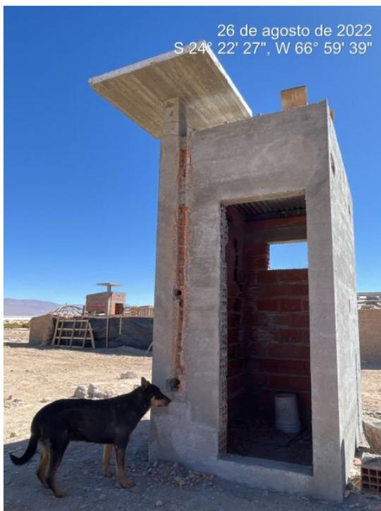
Fotografía 81. Núcleo húmedo en construcción
