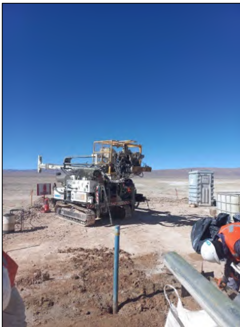
Figura 8-2: Instalación de cañerías en la perforación
