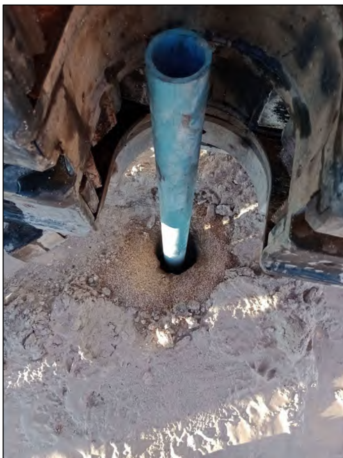
Figura 8-1: Instalación de la cañería en el pozo BH-17
