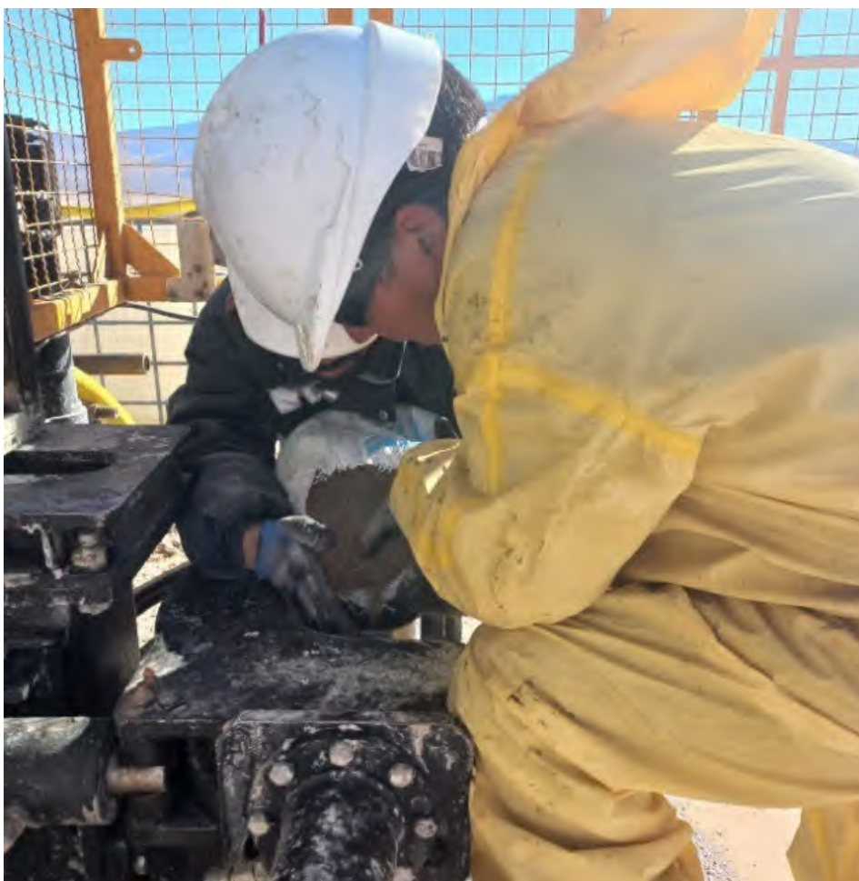
Figura 8-1: Imagen tomada durante la instalación del piezómetro BH19
