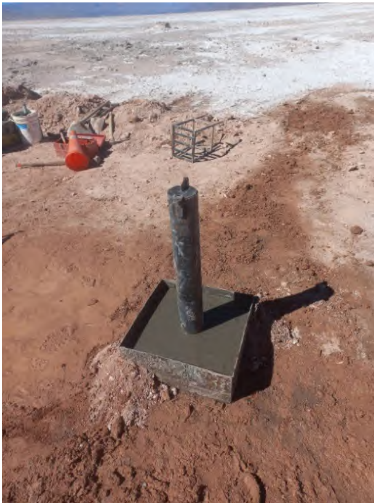
Figura 8-1: Tubo metálico de superficie y dado de hormigón
