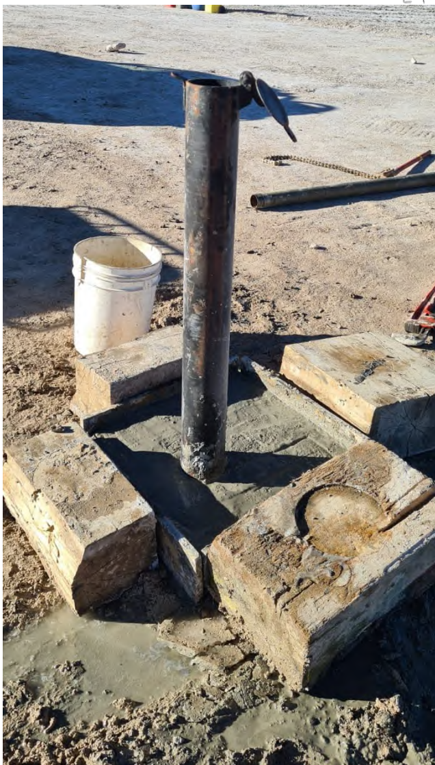
Figura 8-1: Tubo metálico de superficie y dado de hormigón durante la perforación BH-18
