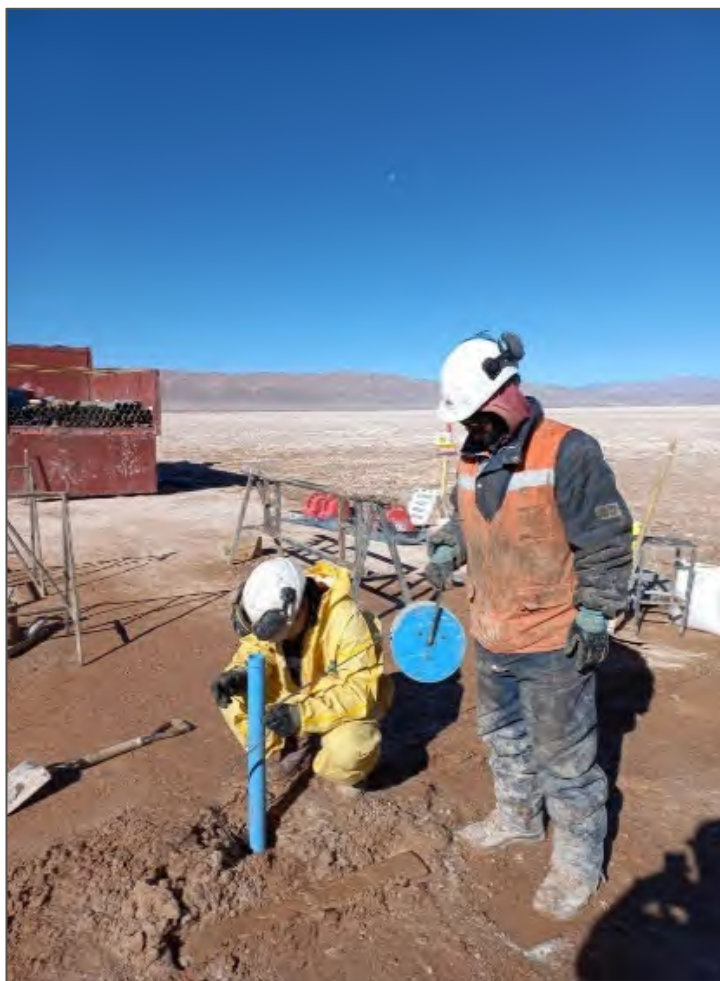
Figura 8-1: Instalación de cañerías durante la perforación BH-10
