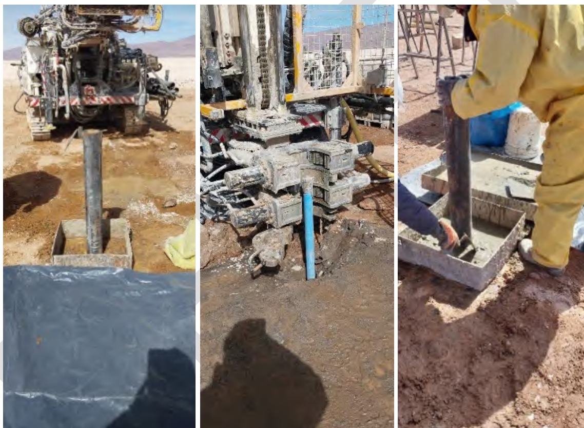
Figura 8-1: Instalación de cañerías en el sondeo BH09
