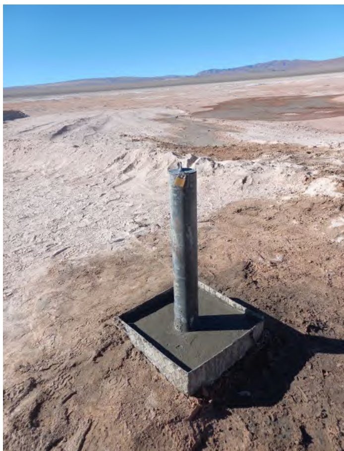
Figura 8-1: Tubo metálico de superficie y dado de hormigón de la perforación
