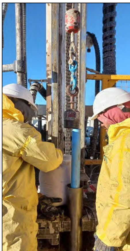
Figura 8-1: Instalación de cañerías en el sondeo BH14
