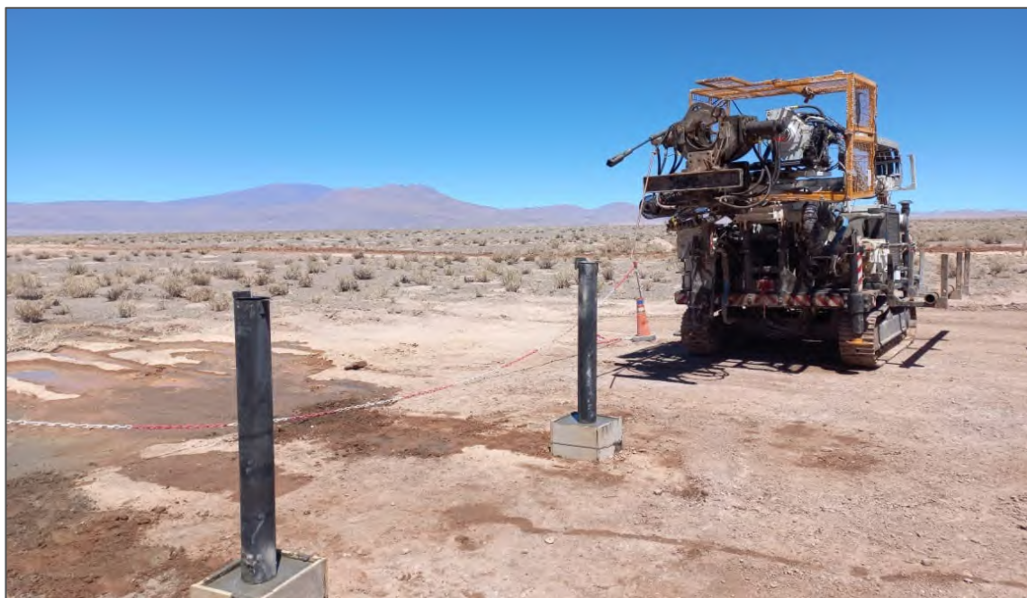
Figura 7-1: Instalación y construcción de brocales metálicos y bases de hormigón
