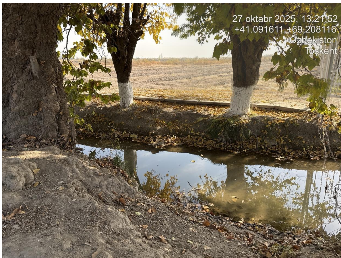
Loyiha hududidagi drenaj kollektori
