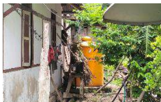
Gambar III-322. Rumah Warga yang telah memiliki Akses Air Bersih di Kecamatan Moa
