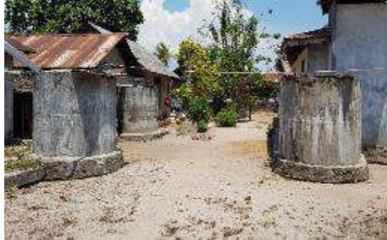
Tangki Penampungan Air Hujan
