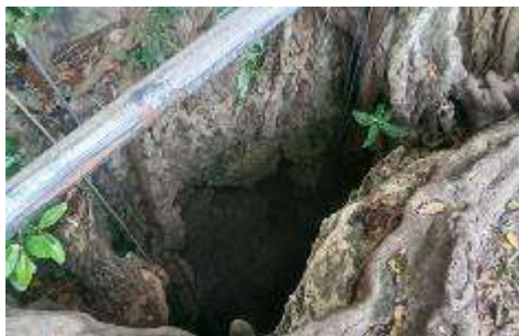
Kondisi Sumur Tua di Desa LTB
