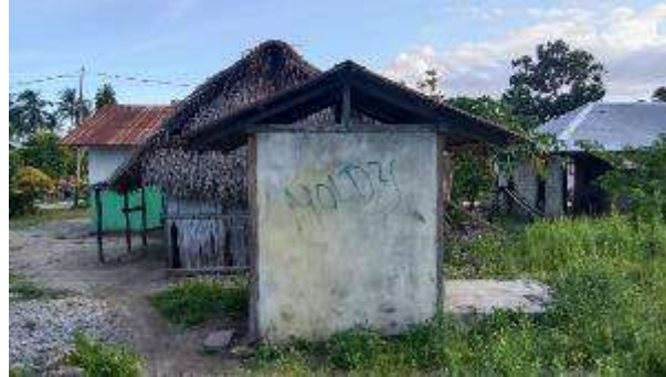
Gambar III-493 Jamban yang ada di Desa Emplawas
