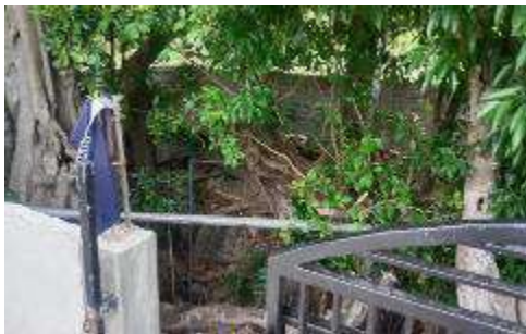
Kondisi Sumur Tua di Desa LTB
