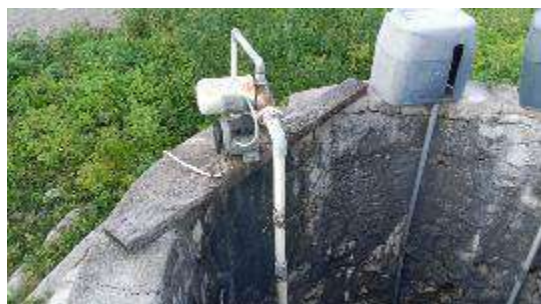
Gambaran Sumur Gali yang ada di Desa Emplawas
