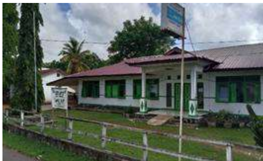
Gedung Rawat Inap di Wilayah Kerja Puskesmas Tapa
