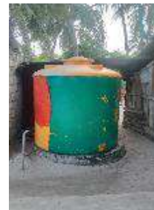
Tempat Penampungan Air Hujan
