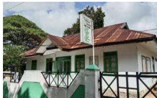
Gedung Pelayanan Tingkat Dasar di Puskesmas Tapa
