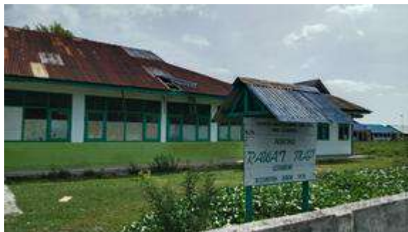
Fasilitas Pelayanan di Puskesmas Induk Letwurung Gedung untuk Rawat Inap
