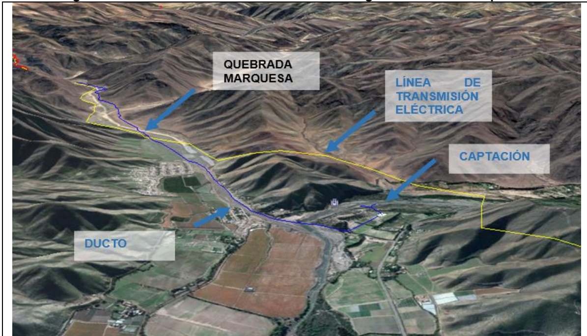
Figura Nº 3.1.7.4. Vista General de la Geomorfología del Sector de Captación
