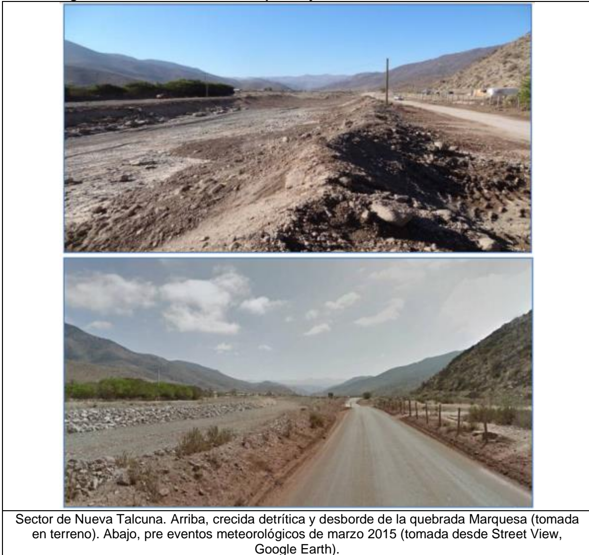
Figura N° 3.1.8.11 Zona Afectada por Flujos de Detritus Sector Nueva Talcuna
