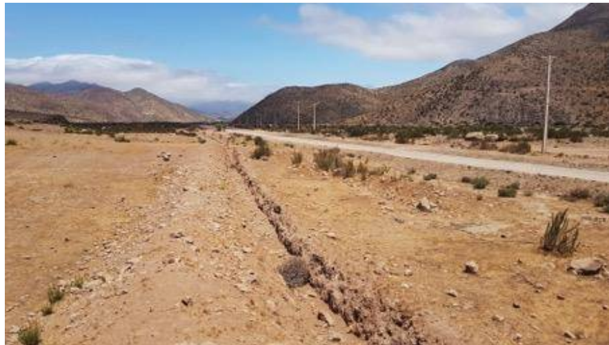
Imagen 4. Área Acueducto, sector La Marquesa.
