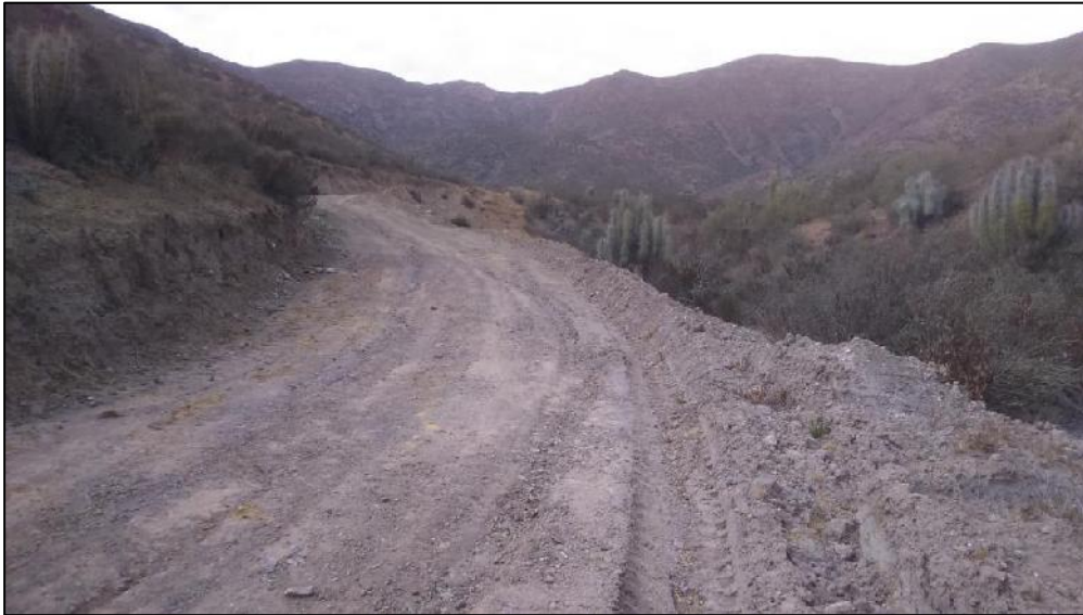
Figura Nº 3.4.1.12. Inicio del Recorrido e Inspección de la LTE UTM H19S 309.279 E / 6.680.491 N
