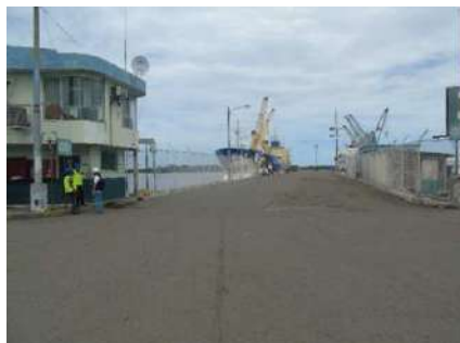
Muelle #1 y Muelle #2
