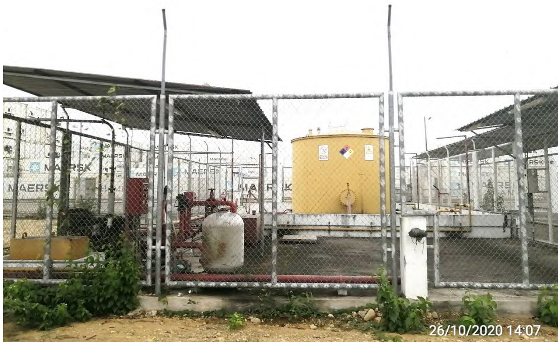
Zona de combustibles, construida en el año 2012
