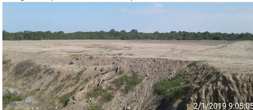
Vista general de piscina de sedimentos No. 3
