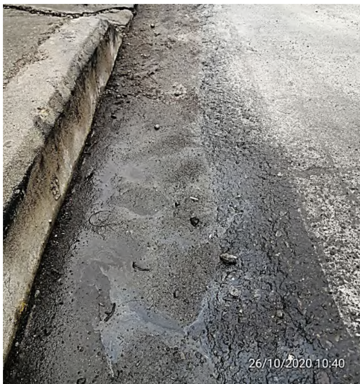
Acceso frontal a Patio 1
