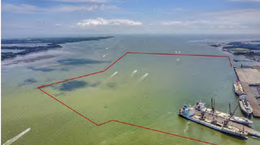
Ilustración 9. Área de dragado en zona de maniobras
