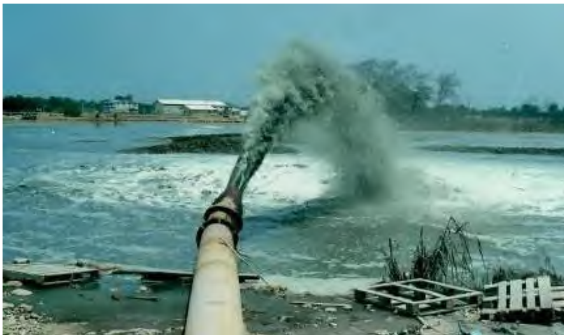
Vertido de sedimentos dragados de los muelles en las piscinas de sedimentos, entre los años 2004- 2009
