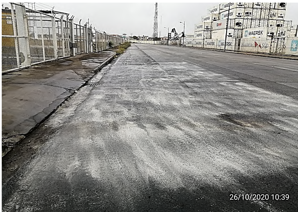
Acceso frontal a Zona de Combustibles
