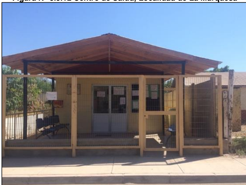
Figura N° 3.9.12 Centro de Salud, Localidad de La Marquesa
