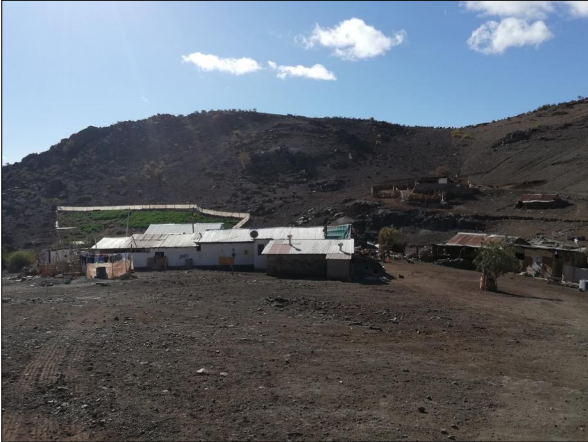
Figura N° 3.9.18 Predio Agrícola e Infraestructura Ganadera, Majada “La Chanca”
