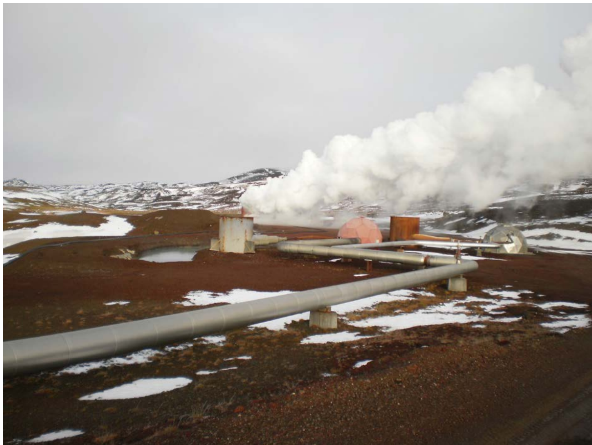
Mynd 17 Dæmigerður frágangur röralagna í gufuveitu frá tveim borholum í Kröflu. Fjær sést í gufu frá hljóðdeyfi þar sem blástursprófanir stand yfir við þriðju holuna.
