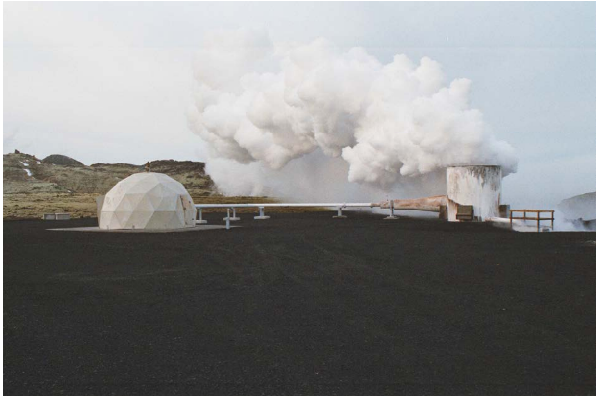
Mynd 15 Hefðbundinn frágangur borholu. Kúluhúsið er utan um sjálfa borholuna og gufan rýkur út um hljóðdeyfinn. Hægra megin við hann rennur affallsvatnið út.
