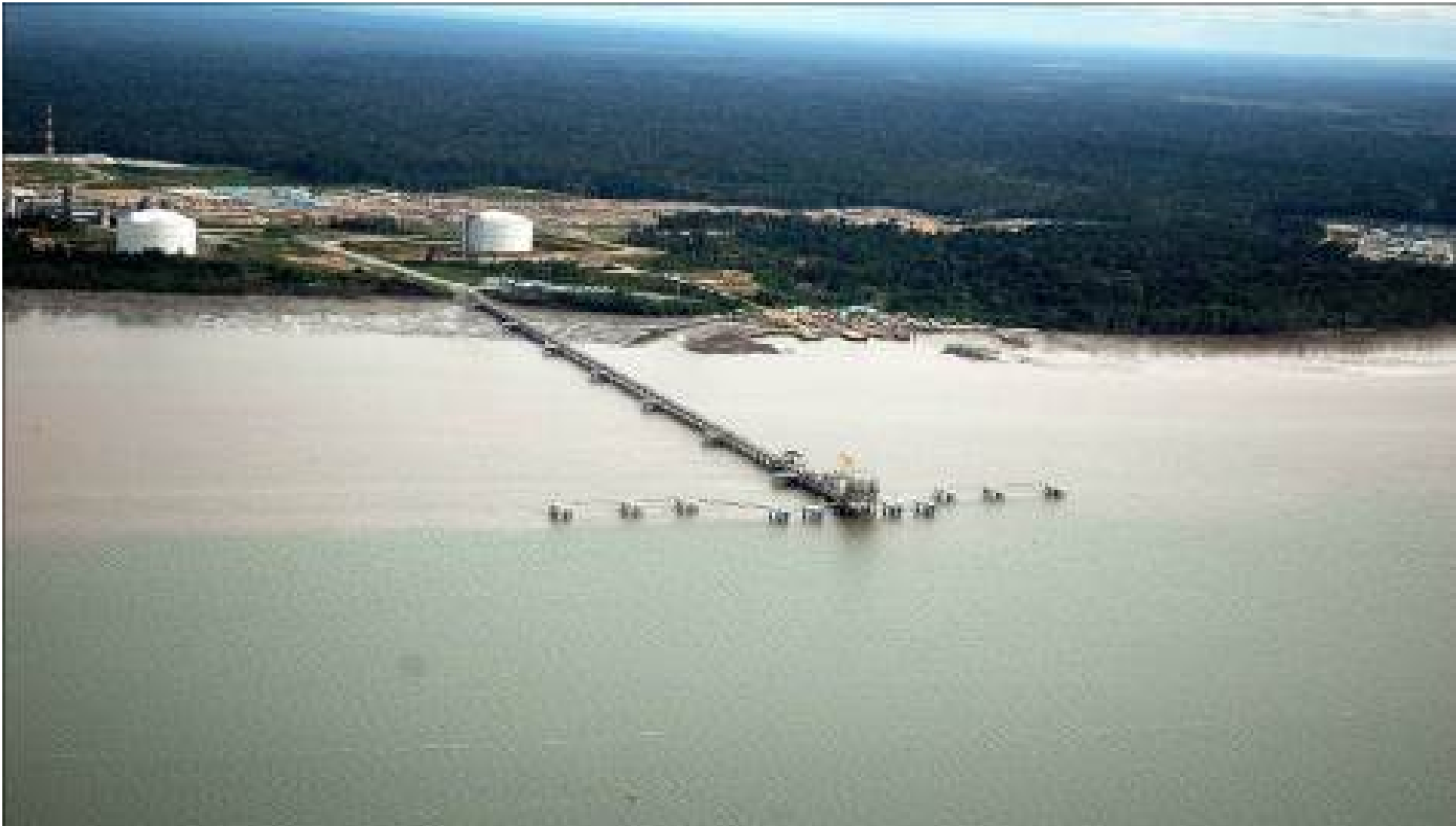
Figure I-53 Existing LNG Jetty
