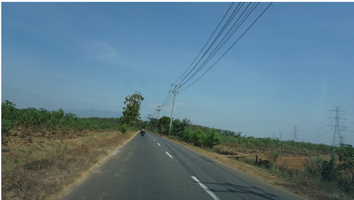
Gambar 2.150. Kondisi Ruas Jalan Lokal Wedelan – Tubanan (Jalan Akses PLTU) Sumber: Survei Lapangan, 2015
