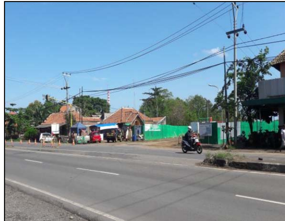
Gambar 4. Akses jalan masuk lokasi PLTU Kapasitas 1x1000 MW Cirebon
