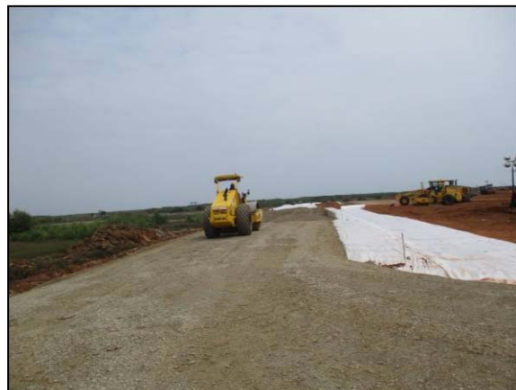
Gambar12. Proses pengerasan akses jalan
