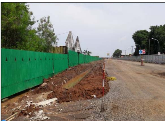
Gambar 5. Penyiapan akses jalan utama PLTU Kapasitas 1x1000 MW Cirebon
