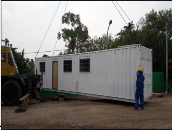
Gambar 7. Penyiapan basecamp pekerja
