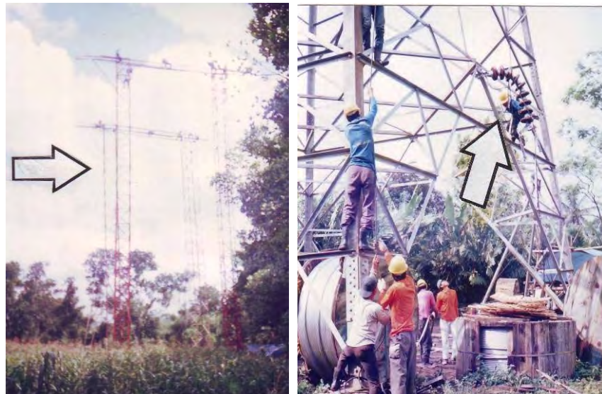
Gambar 1.11. Ilustrasi pemasangan scaffolding untuk jaringan transmisi yang melintasi dengan jaringan listrik eksisting dan menaikan insulator strings ke travers
