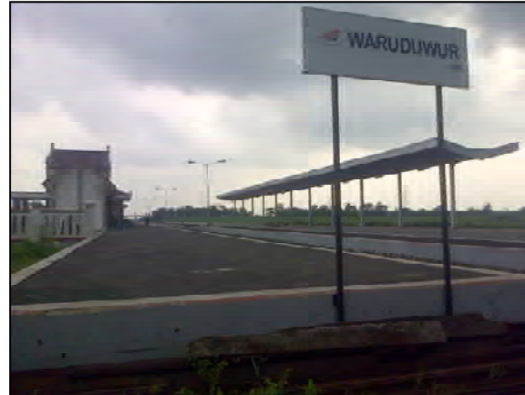
Gambar 2. Stasiun Waruduwur yang terletak di antara T.03 – T.04
