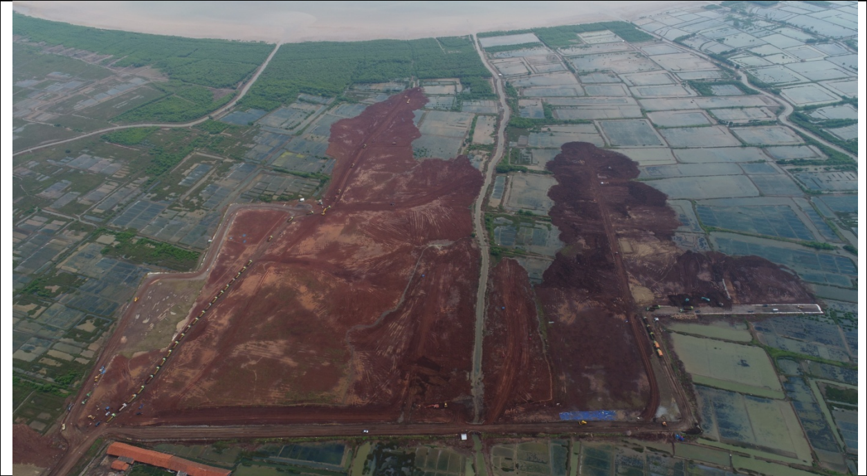
Overview lahan yang sedang dilakukan pematangan
