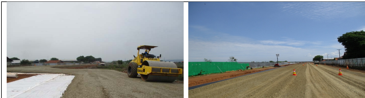
Gambar 1-8 Konstruksi jalan akses
