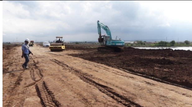
Pengurugan dan pemadatan pada jalan akses
