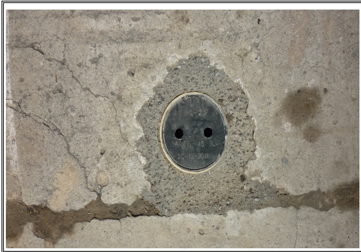
Foto N° 10: Sondeo SMQ - 25 -Tapa de Sondeo
