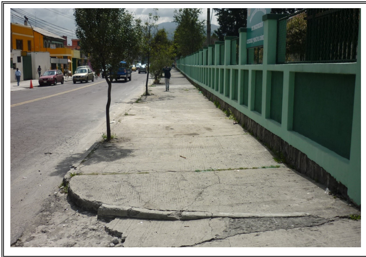
Foto N° 1: Sondeo SMQ -25 - Inicio de Sondeo
