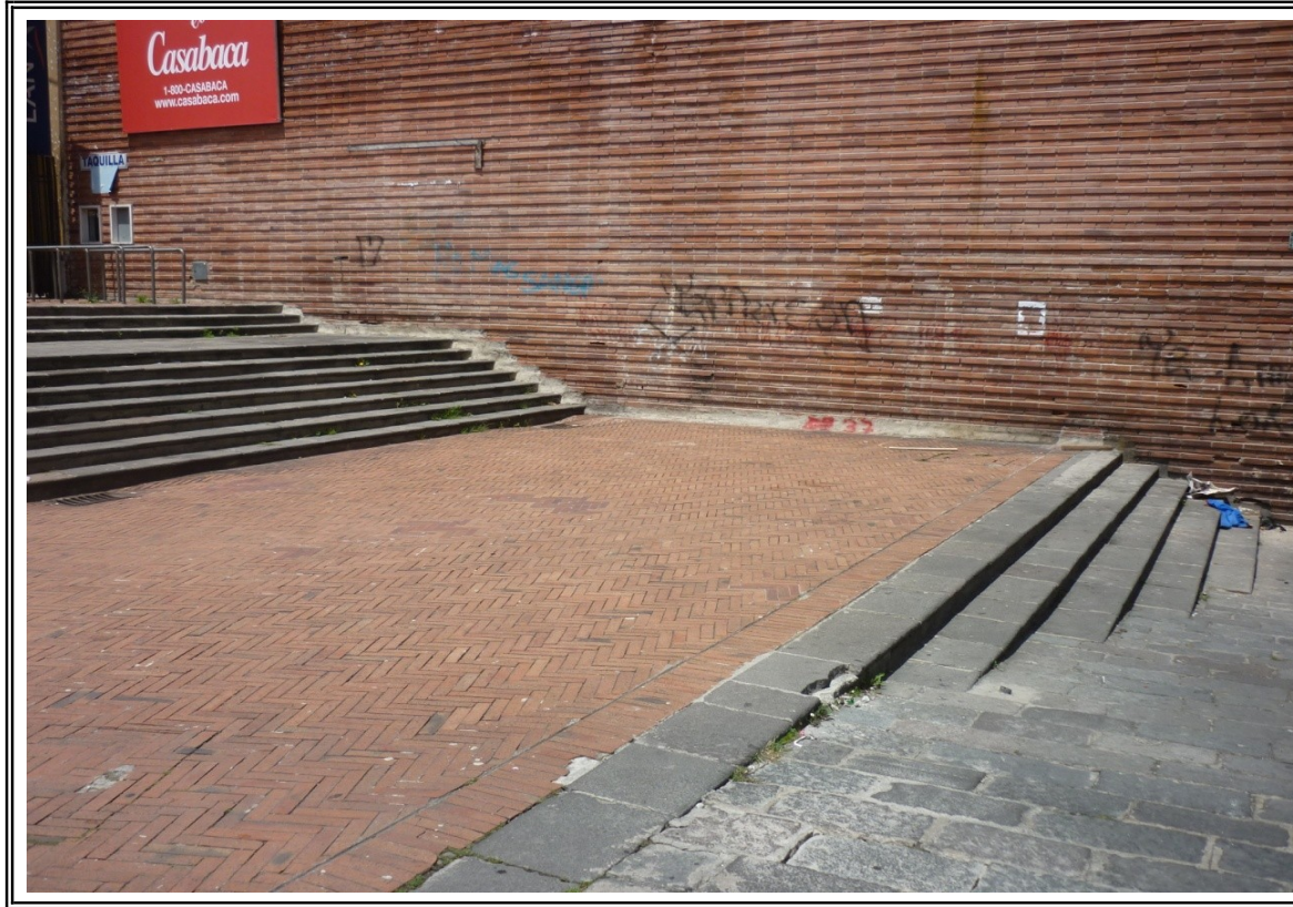
Foto N° 1: Sondeo SMQ - 37 - Inicio de Sondeo
