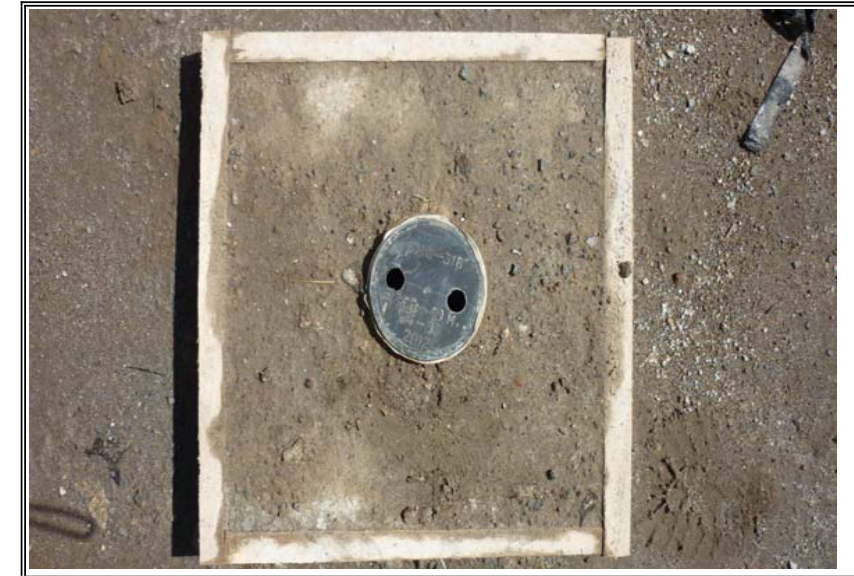
Foto N° 1: Sondeo SMQ - 31B - Sistema de cerradura del Sondeo
