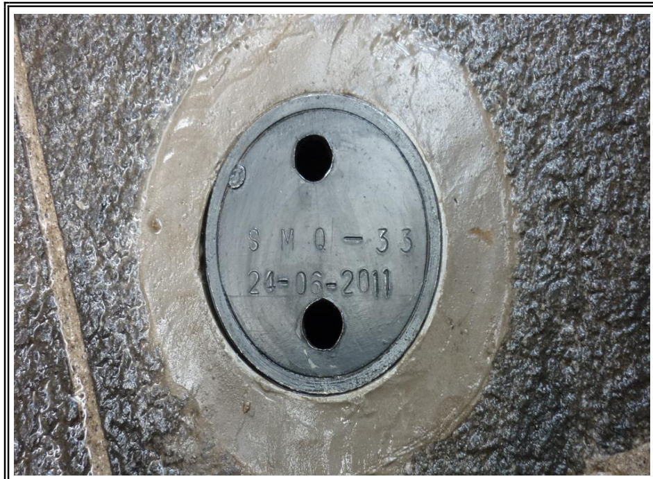
FINALIZACIÓN DEL SONDEO SMQ-33
