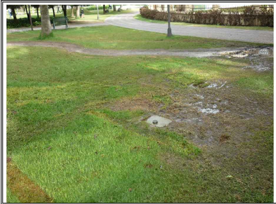
FINALIZACIÓN DEL SONDEO SMQ-38
