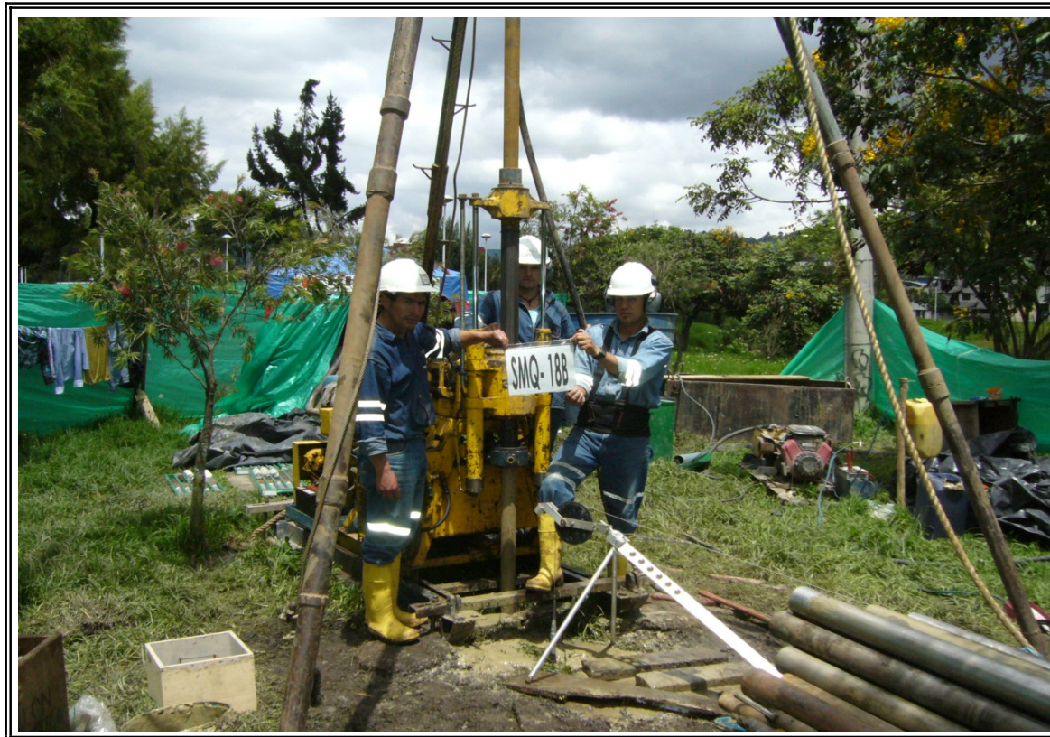
Foto N° 1: Sitio de perforación del sondeo SMQ - 18B
