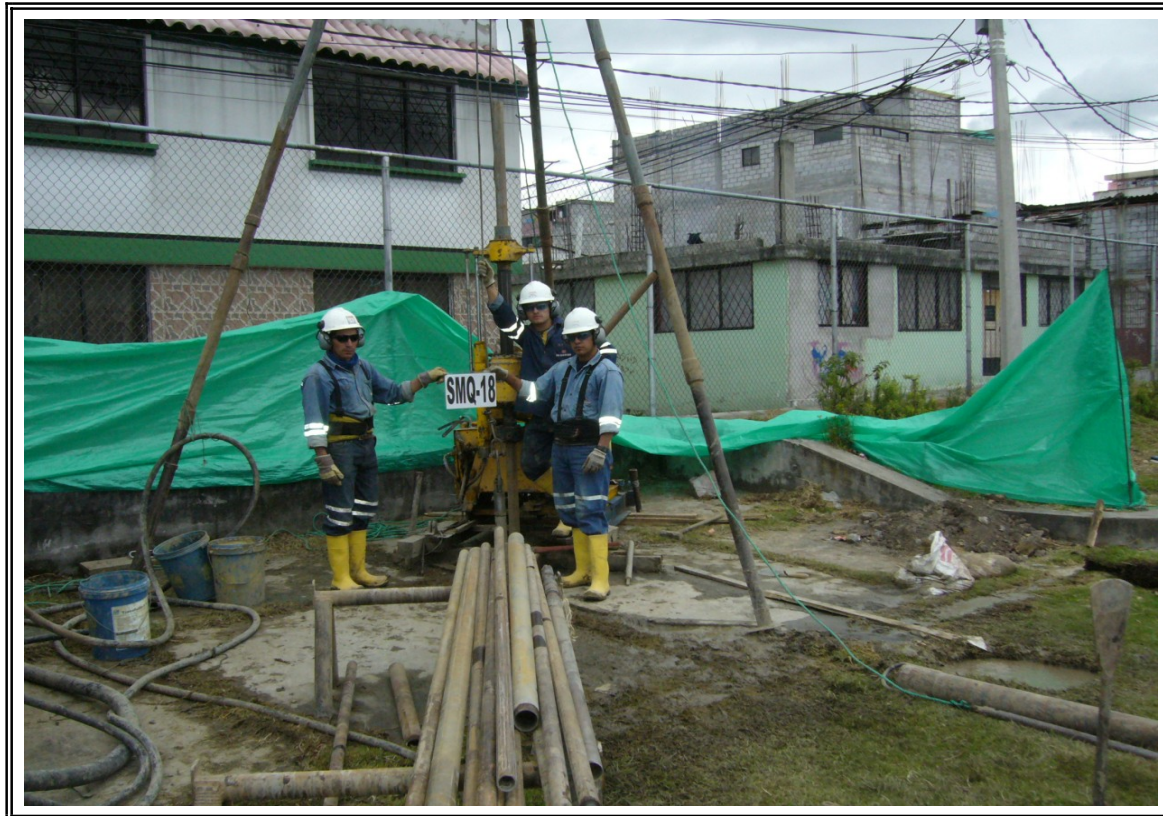
Foto N° 1: Sitio de perforación del sondeo SMQ - 18
