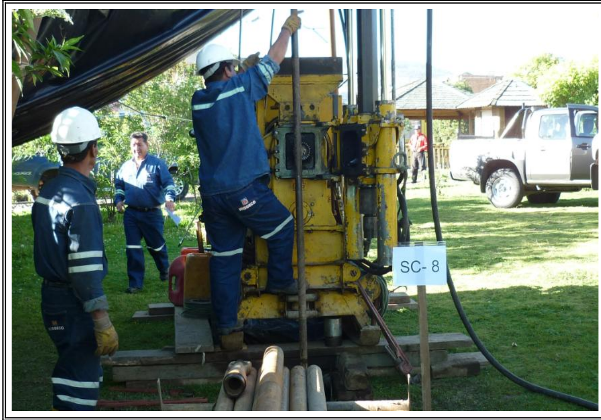
Foto N° 1: Sitio de perforación del sondeo SMQ - 24.
