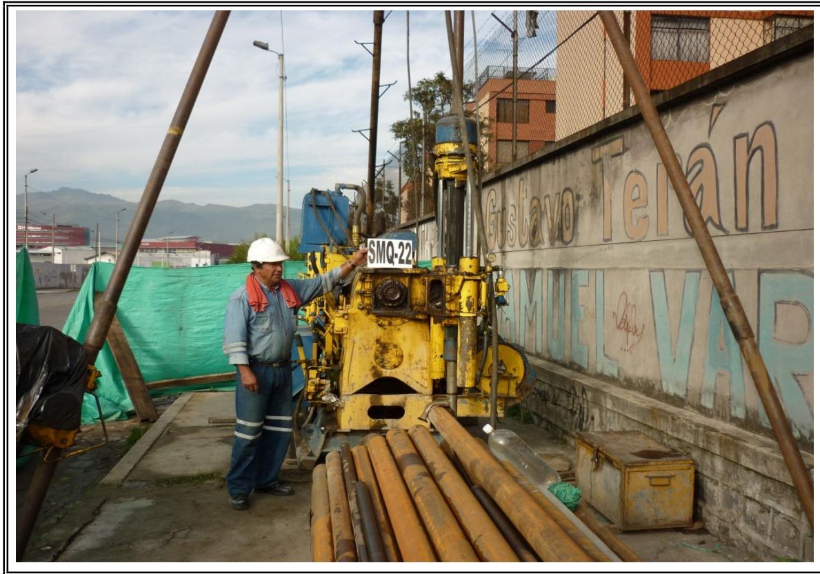
Foto N° 1: Sitio de perforación del sondeo SMQ - 22
