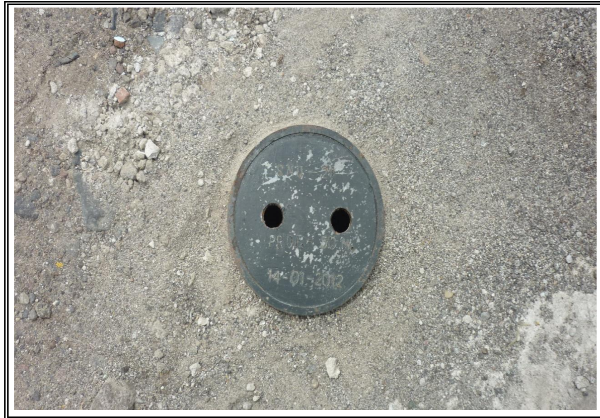
Foto N° 1: Sitio de perforación del sondeo SMQ - 21.
