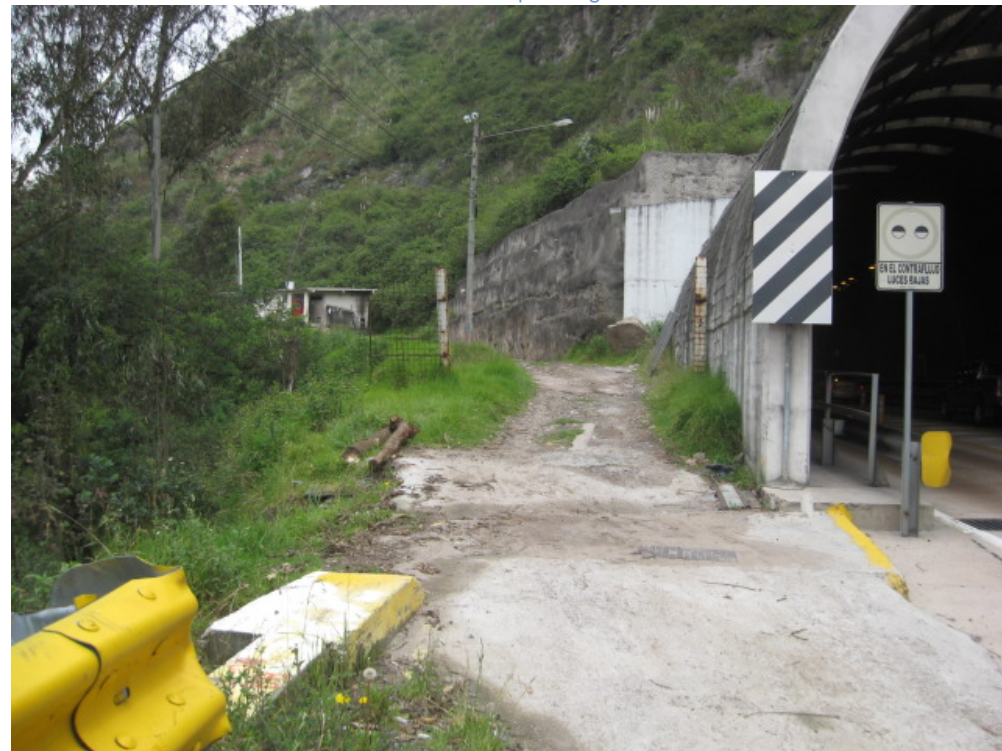
Acceso al área de escombrera
