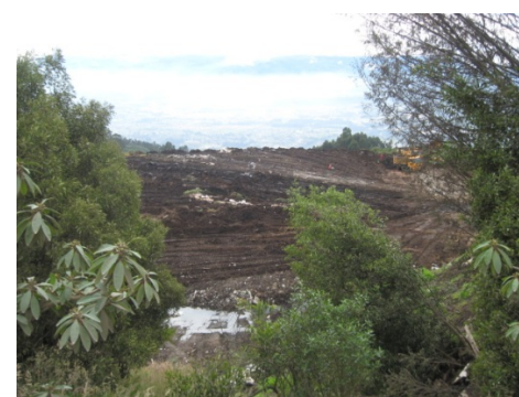
Figura 4. Vista de la escombrera
