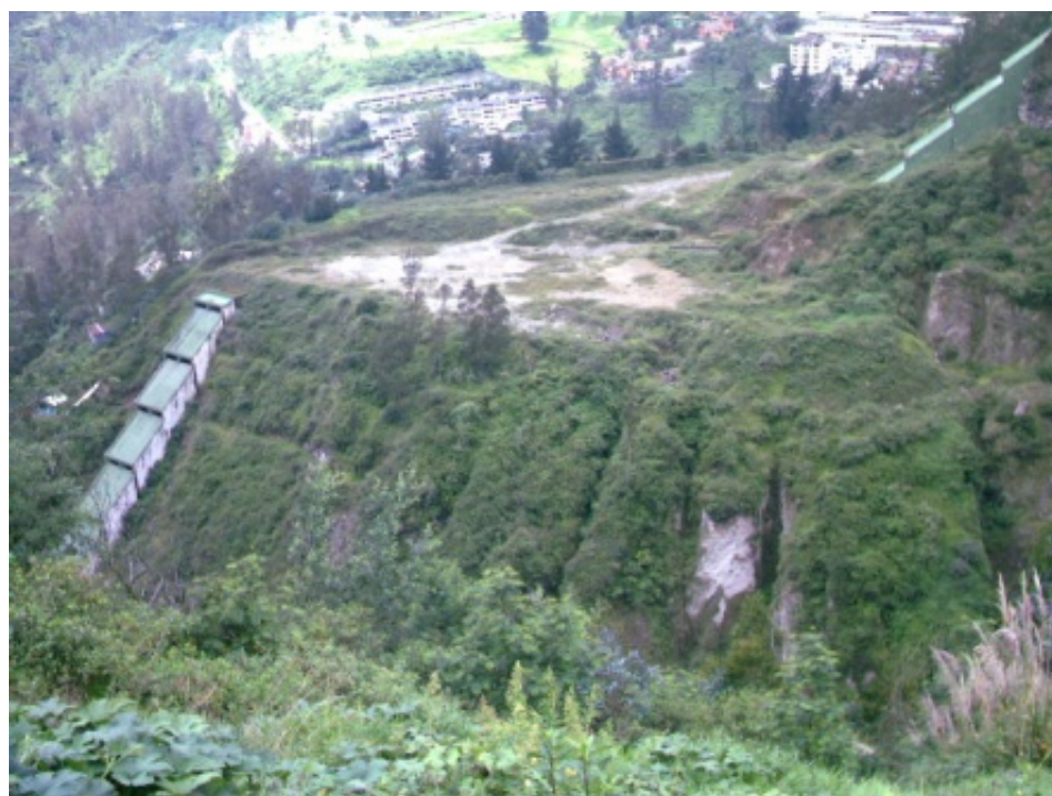
Detalle áreas planas y pendientes de sitio. Existe una central de generación eléctrica aguas abajo
