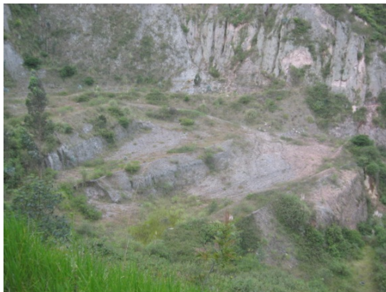
Figura 1. Taludes rocosos de la Quebrada S/N. Fuente: Investigación de campo. BIOPLANNING. 2012
