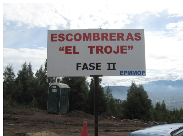
Figura 1. Escombrera "El Troje II"
