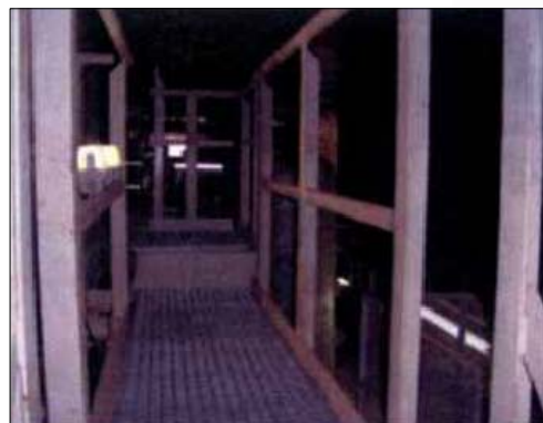
RECRECIDO DE BARANDILLAS EN EL DEPÓSITO DE MORTERO. PROTECCIÓN FRENTE AL RIESGO DE CAIDA EN ALTURA
