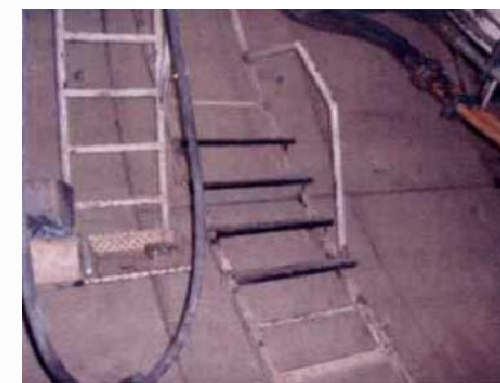
COLOCACIÓN DE ASIDEROS Y PLATAFORMAS EN PELDAÑOS EN EL ACCESO POR ESCALAS
