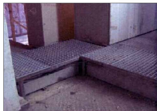
PLATAFORMAS DE TRAMEX PARA PROTEGER ZONAS DE CABLES CONDUCTORES DE CONTACTOS Y APLASTAMIENTO
