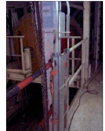
MEDIDAS DE EMERGENCIA. CAMILLAS EN TUNELADORA
