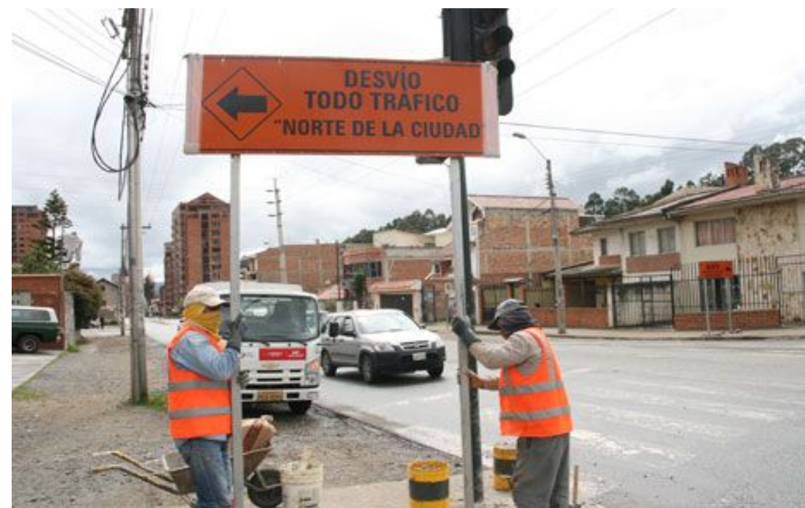
Figura 11.12 Desvío de tráfico por obras en la ciudad de Cuenca, Ecuador
