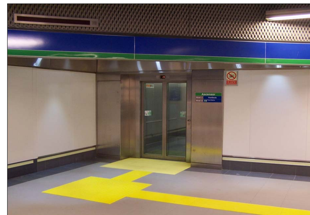
Fuente: Metro Madrid. Ascensor interior de estación con encaminamiento
