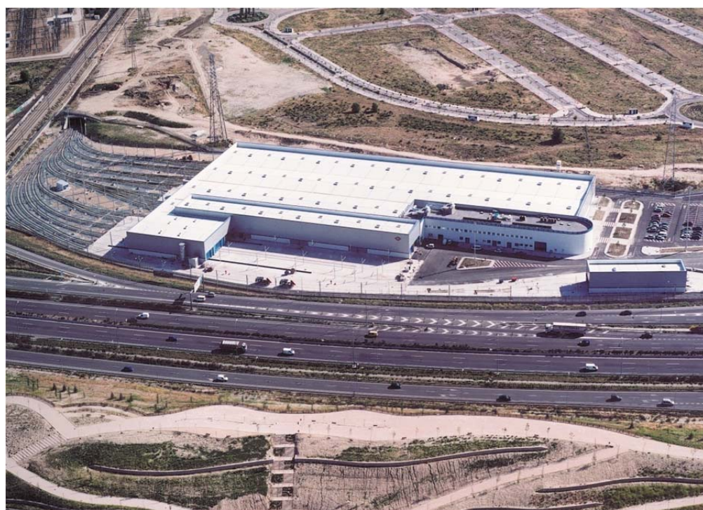
Fuente: Metro Madrid. Vista aérea de una cochera
