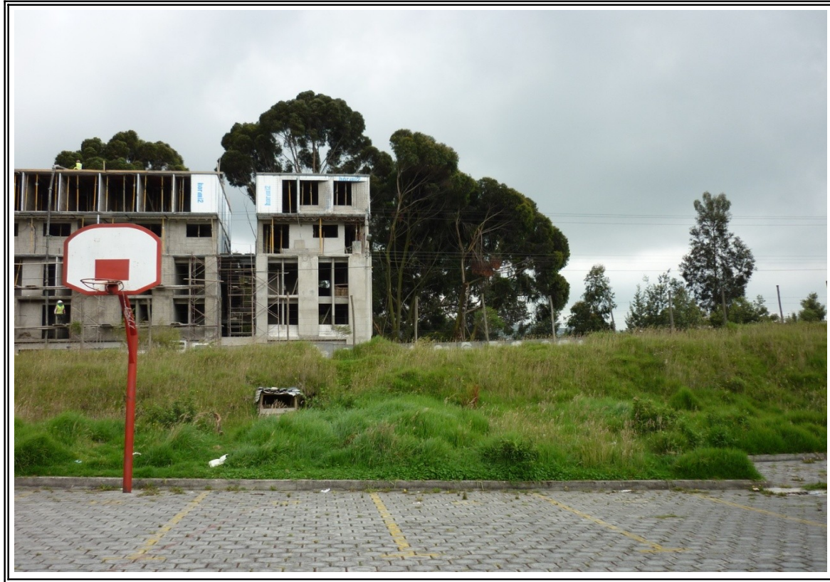
Foto N° 1: Sondeo SMQ - 64 - Inicio de Sondeo
