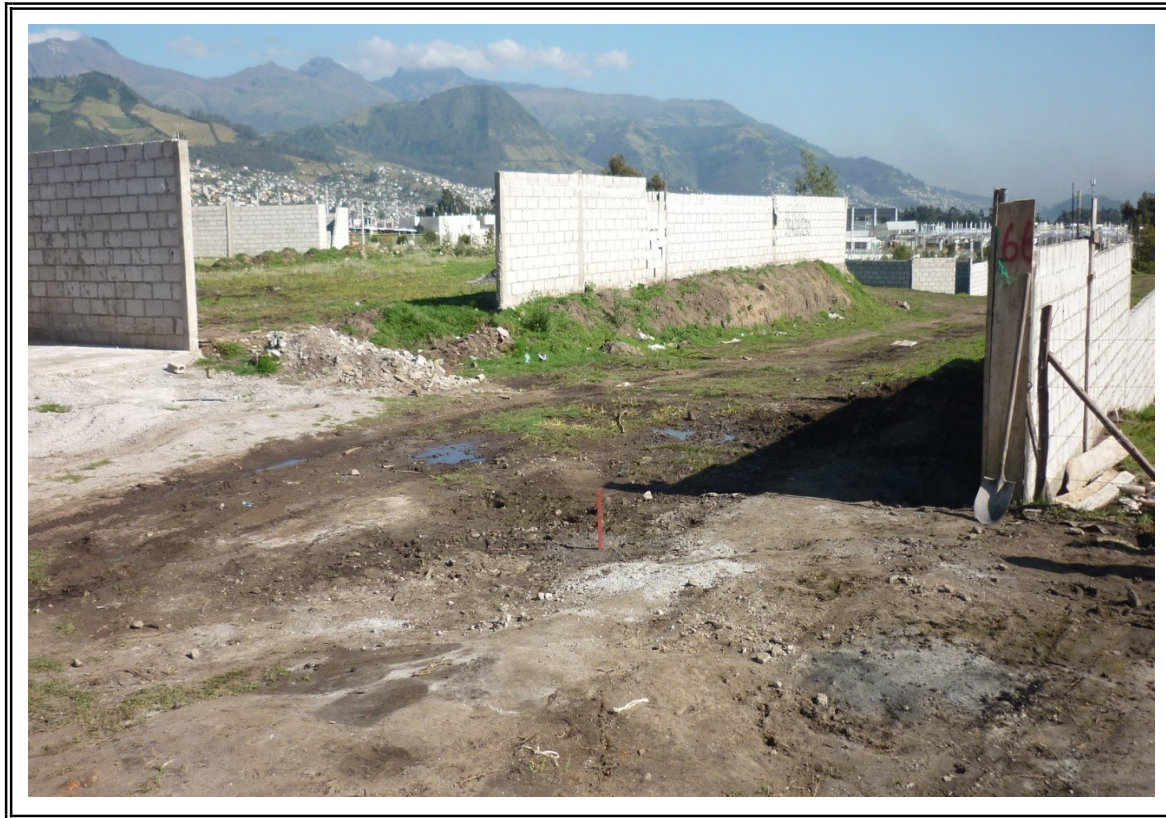
Foto N° 1: Sondeo SMQ -66- Inicio de Sondeo
