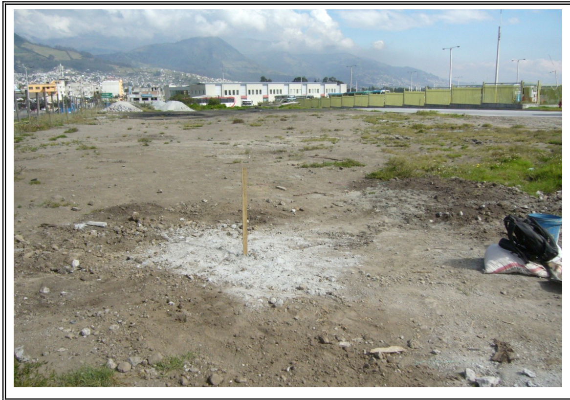
Foto N° 1: Sondeo SMQ -65- Inicio de Sondeo
