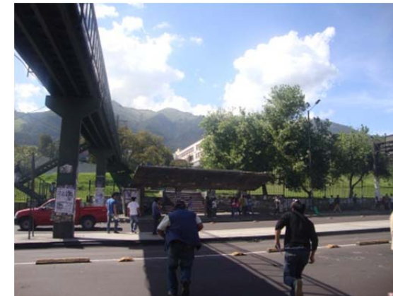
FOTO 48. BAJO EL PUENTE PEATONAL, AV. AMÉRICA. VISTA OESTE.
