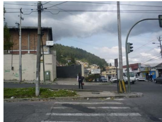
FOTO 37. CRUCE AV. 5 DE JUNIO Y AV. RODRIGO DE CHÁVEZ. VISTA NORTE
