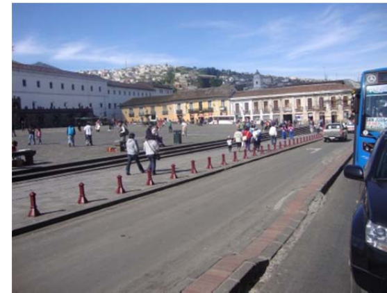
FOTO 39. CALLE BENALCÁZAR, FRENTE A LA IGLESIA DE SAN FRANCISCO. VISTA NORTE
