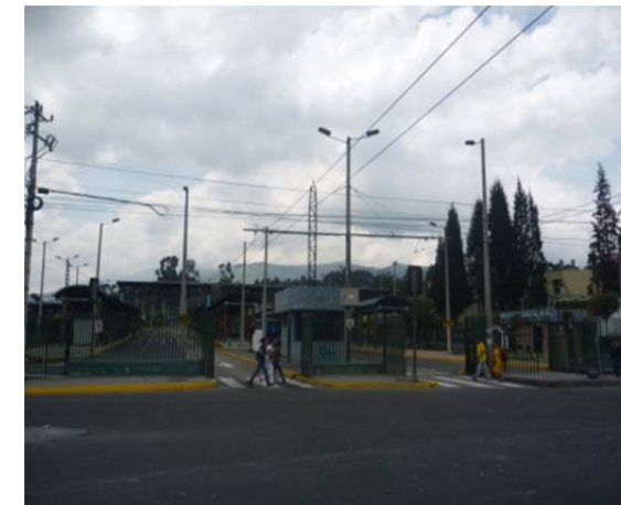
FOTO 15 VISTA FRONTAL A LA ESTACIÓN DEL TROLE BUS MORAN VALVERDE
