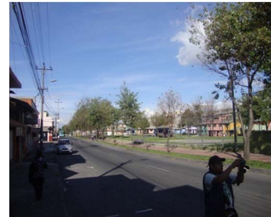
FOTO 22. AV. CARDENAL DE LA TORRE, VISTA NORTE
