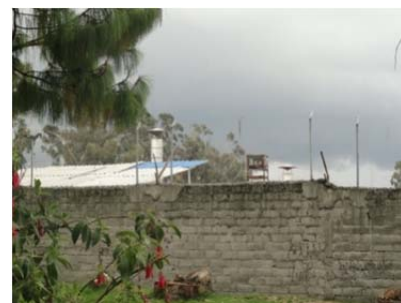
FOTO 19. ALREDEDORES DE LA ESTACIÓN MA-5;
