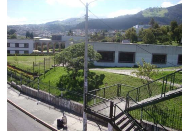
FOTO 47. PASO PEATONAL AV. AMÉRICA. UNIVERSIDAD CENTRAL DEL ECUADOR. VISTA OESTE.
