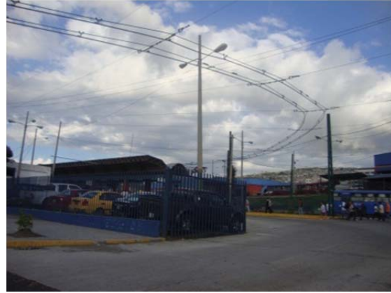
FOTO 26. ENTRADA SUR DE LA ESTACIÓN DEL TROLE BUS EL RECREO
