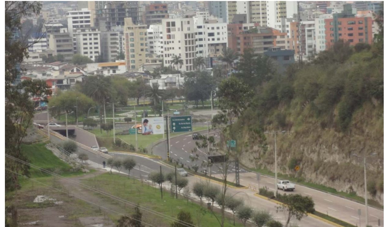
FOTO N°69. DESDE EL PUENTE HACIA ABAJO ENTRADA AL TÚNEL GUAYASAMÍN
