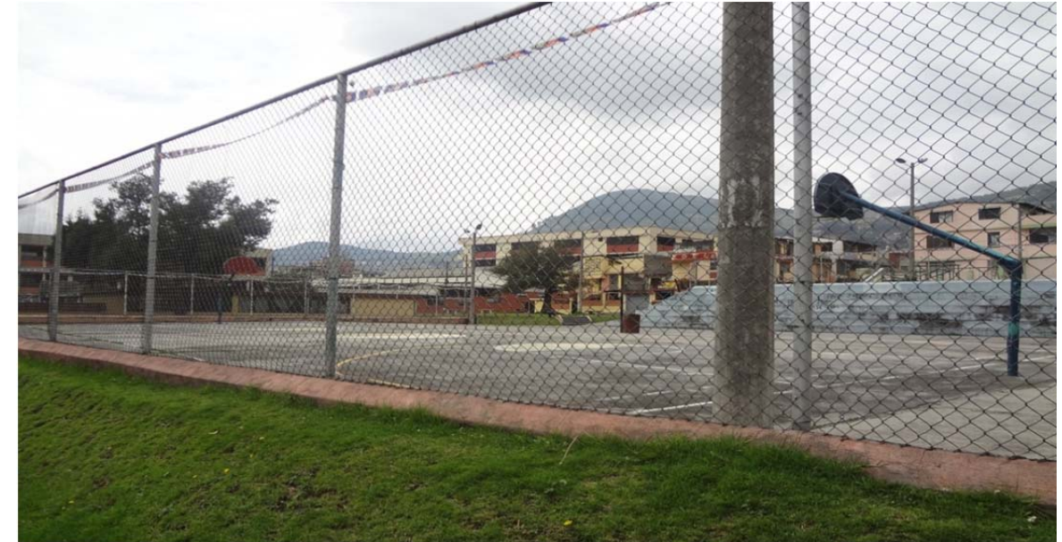
FOTO N°23. CANCHA DEPORTIVA PAVIMENTADA EN LA AV. RODRIGO DE CHÁVEZ Y JACINTO COLLAHUASO
