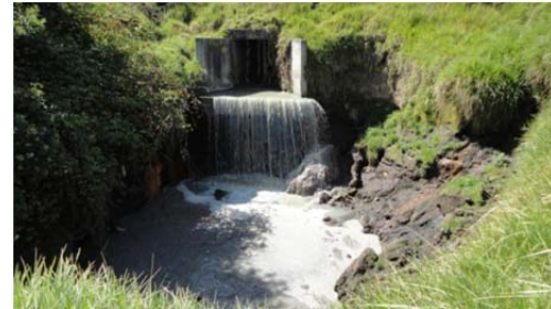
FOTO 4. DESCARGAS UBICADAS AGUAS ARRIBA DEL PUNTO DE MUESTREO MA-1
