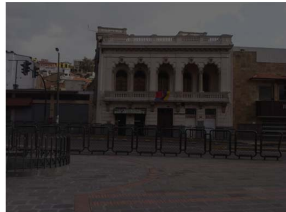
FOTO 15.CONDICIONES PROPICIAS PARA MEDICIÓN DE RUIDO DE FONDO EN LA ESTACIÓN ALAMEDA
