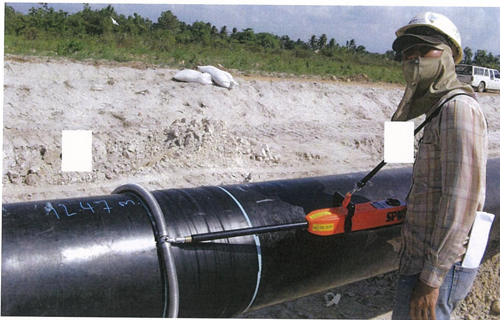
รูปที่ 2.6-6 : การตรวจสอบสารเคลือบผิวท่อภายนอกด้วยวิธี Holiday Test
