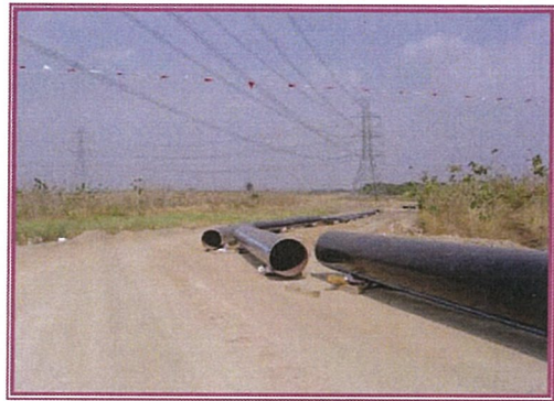
2. ขนส่งและเรียงท่อบริเวณพื้นที่ก่อสร้าง
