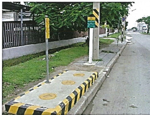
ขั้นที่ 5 : พื้นที่หลังการก่อสร้างแล้วเสร็จ
