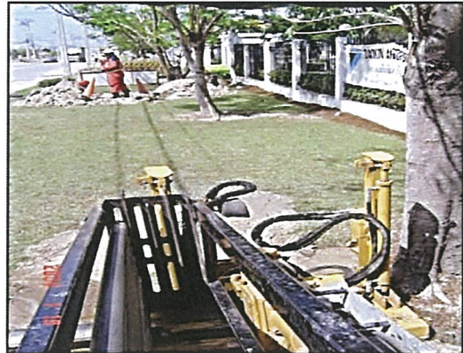
ขั้นที่ 2 : การเตรียมพื้นที่ก่อนการเจาะลุด
