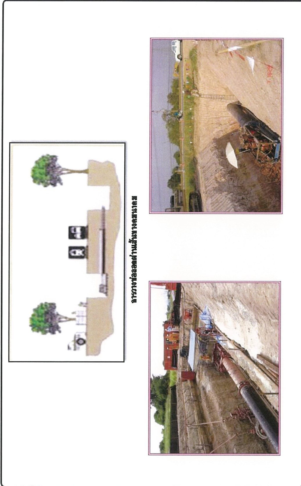
รูปที่ 2.6-10 : การก่อสร้างด้วยตันลอด (Boring)
