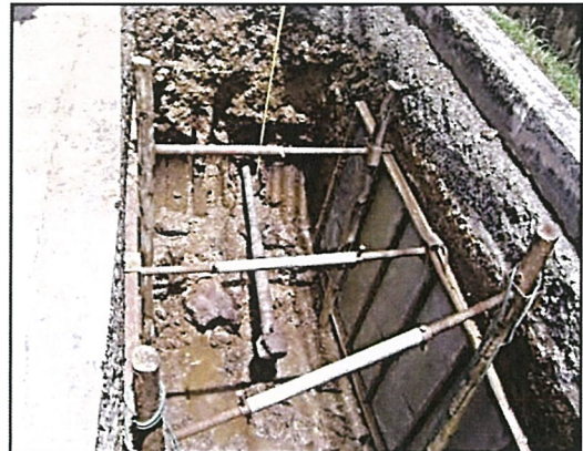
ขั้นที่ 4 : จุดเชื่อมต่อ (Tie-In) กับท่อก๊าซ
