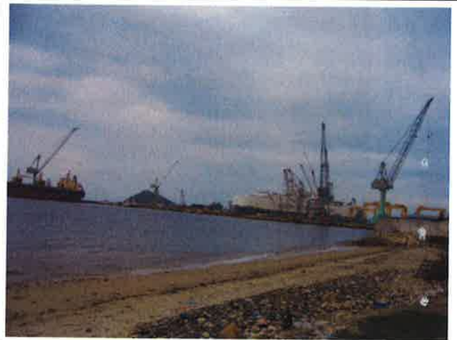
Khu vực nhà máy đóng tàu Vinashin xã Ninh Phước
