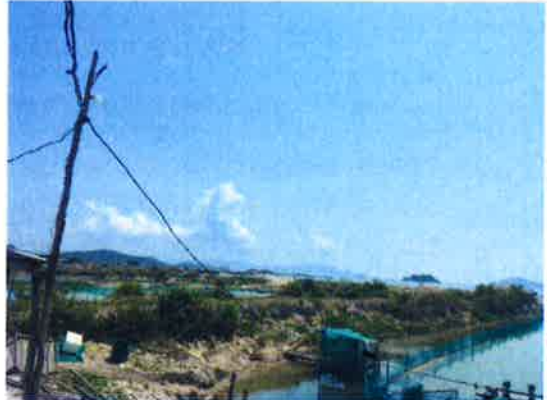
Hình 1-4. Hiện trạng mặt bằng khu vực nhà máy chính
