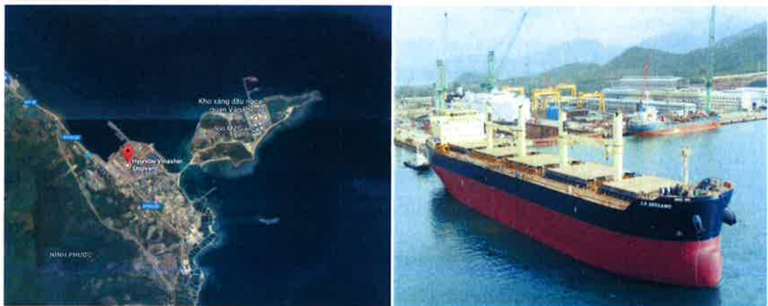
Hình 1-8. Vị trí và hình ảnh Nhà máy đóng tàu Hyundai – Vinashin
