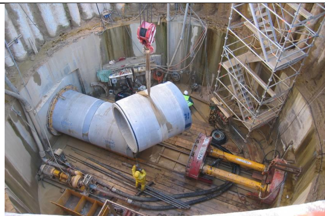
Tunelado de tramos para tuberías submarinas (posteriormente este pique dará origen a sentina de captación de agua de mar y cámara de descarga de salmuera)
