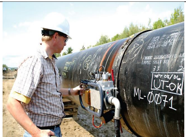
Inspección de soldaduras.
