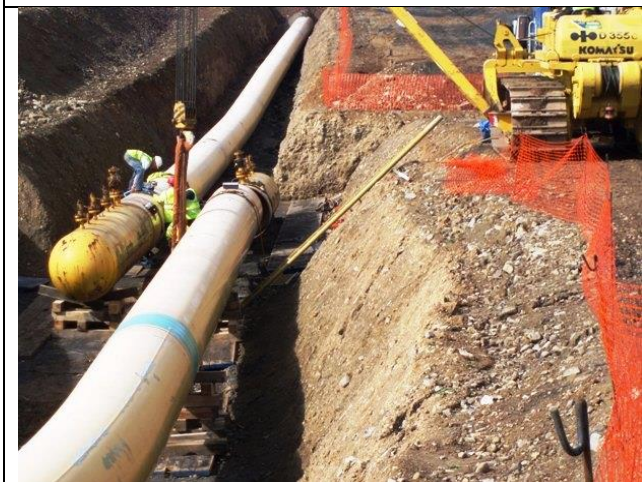
Calibración y limpieza de la tubería.
