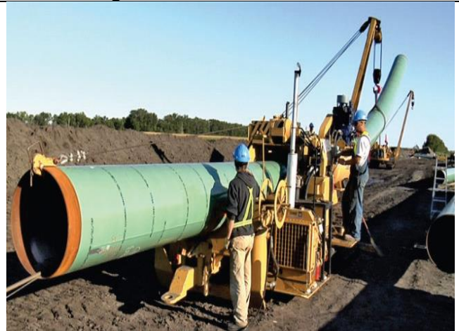
Curvado de tubería.
