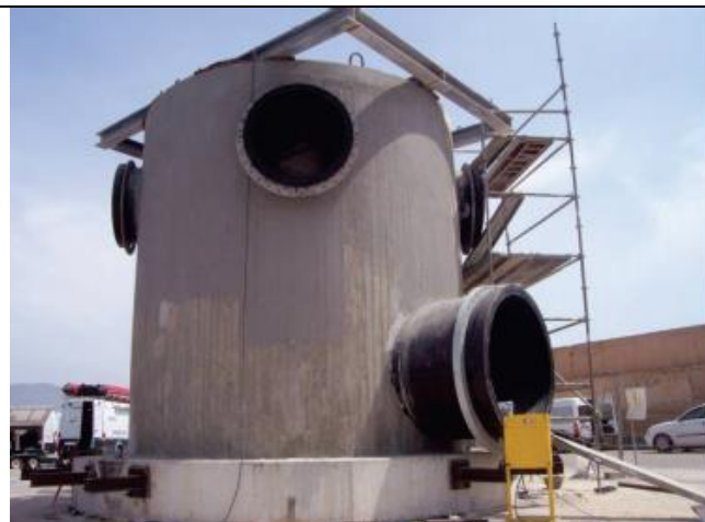
Cajón o estructura captación de agua de mar.
