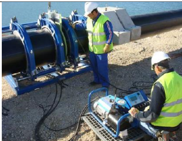
Proceso de soldadura de tuberías.
