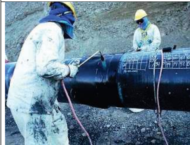
Revestimiento de uniones soldadas.
