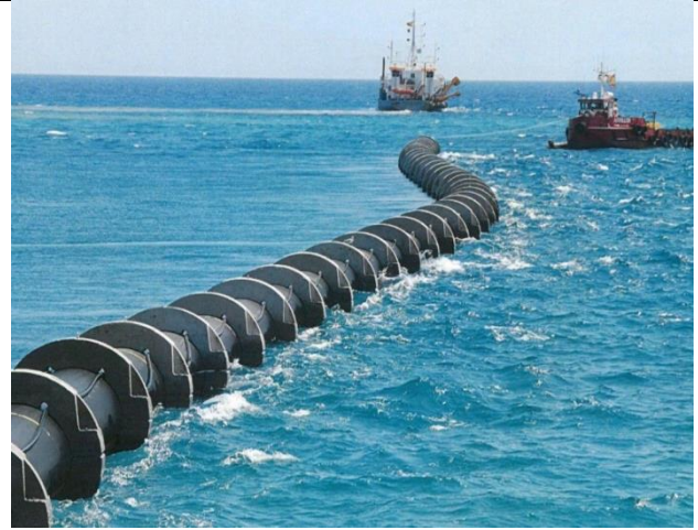
Lanzamiento y remolque de tuberías en el mar.
