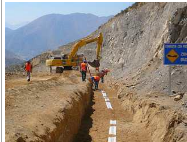
Cobertura final y colocación cinta de advertencia.
