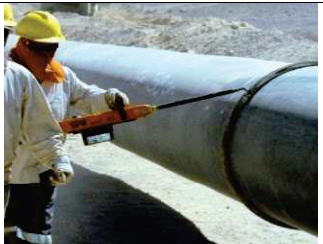
Inspección de revestimiento de soldaduras.
