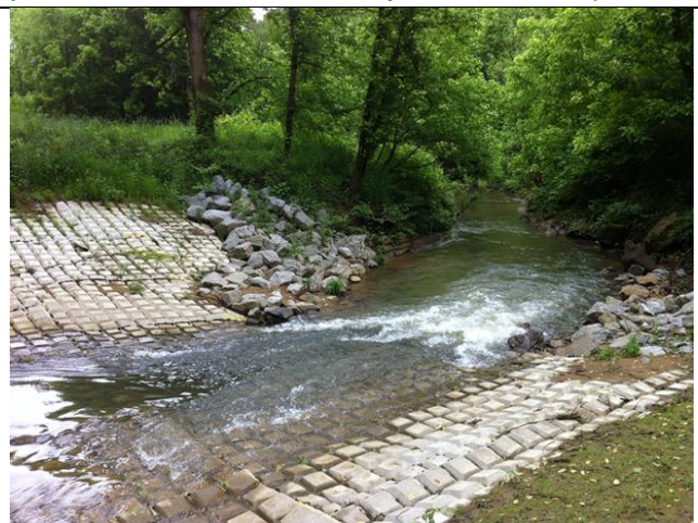
Recomposición de la pista (obras de saneamiento, reparación de taludes, restauración de quebradas, instalación de señalética, reposición de cierros).
