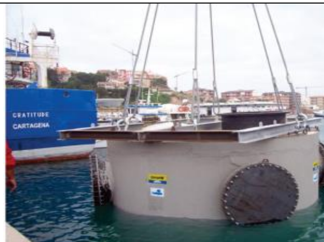
Instalación de cajón de captación de agua.
