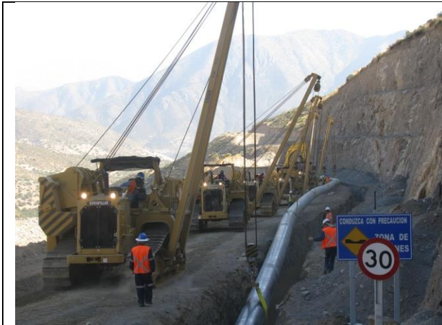
Bajada de la tubería a la zanja.
