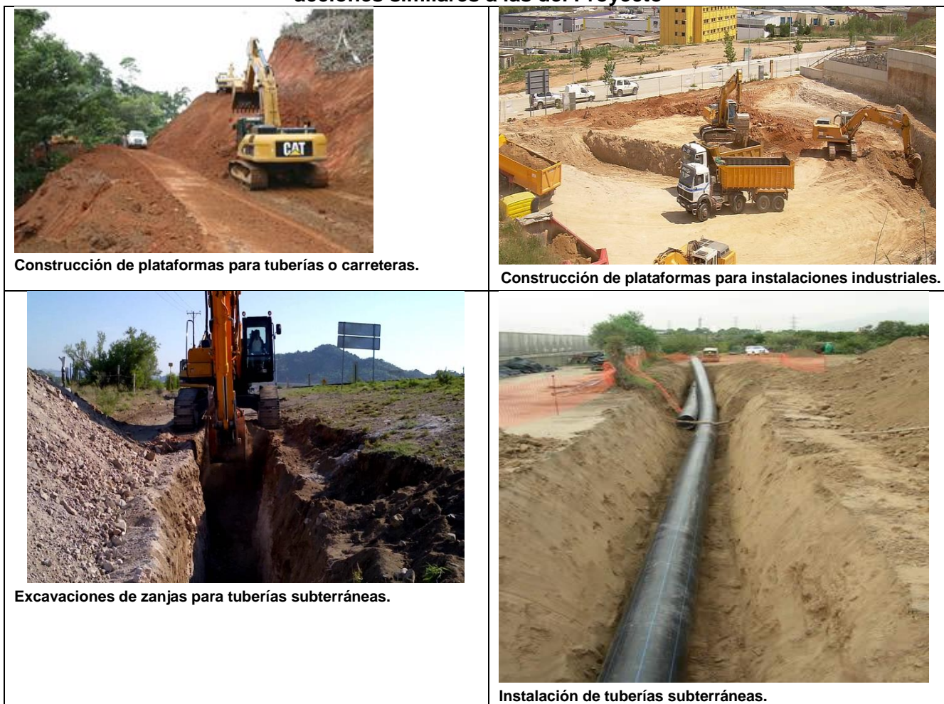
Figura DP-79: Imágenes referenciales respecto a ejecución de obras terrestres y acciones similares a las del Proyecto
