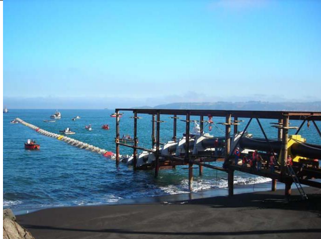
Instalación de riel o rampa provisoria de lanzamiento de tuberías.
