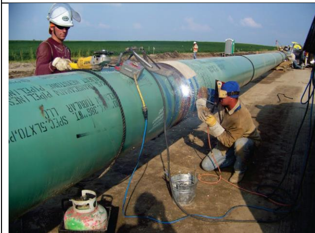
Soldadura de tubería.
