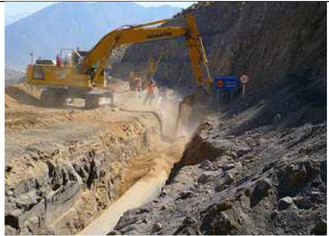
Tapado de la tubería.
