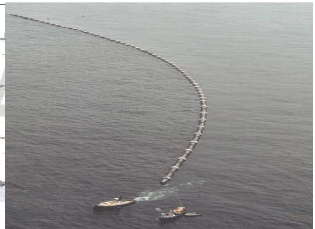
Remolque de tubería en el mar.
