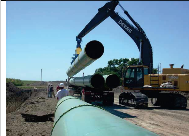
Ubicación de tuberías al costado de zanja o excavación.
