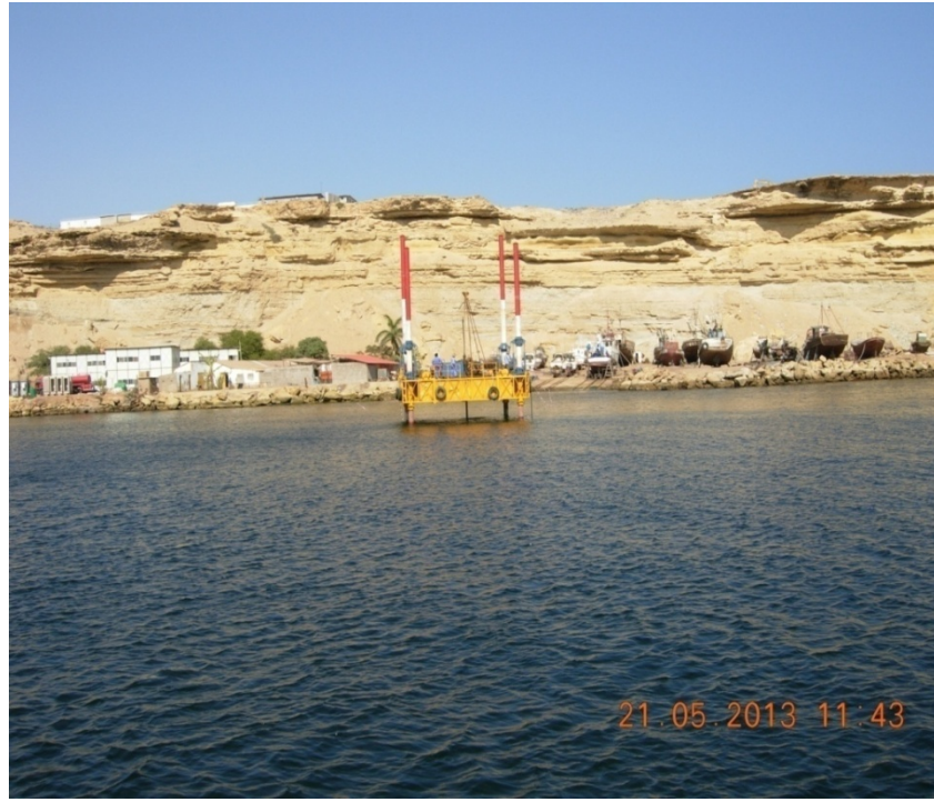
Figura 13 - Plataforma de perfuração auto-elevadora usada na investigação do solo no fundo do mar em Namibe
