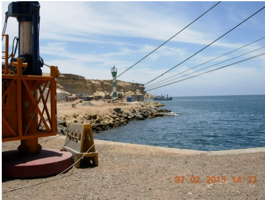
Figura 3 - Porto de Namibe – Vista geral da área designada para a construção de um novo terminal de contentores e ponte-cais
