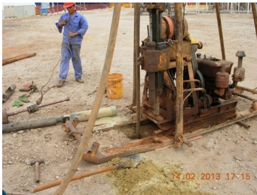
Figura 14 - Investigação do solo terrestre no Porto de Namibe
