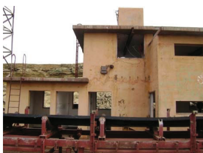
Edifício de Lavagem
