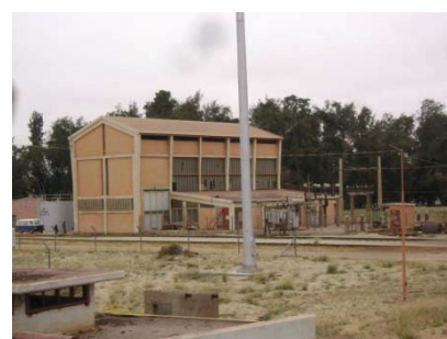
Edifício dos geradores
