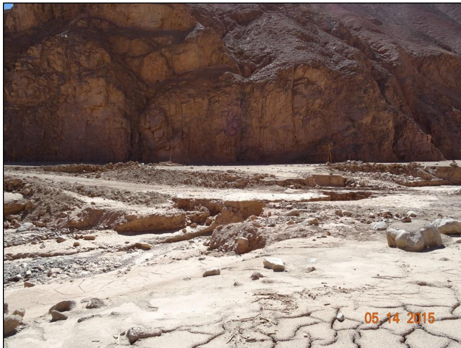
Figura 3.2.4-29. Cortes de camino por crecidas en quebrada Maní
