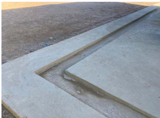
รูปที่ 3-21 ร่องระบายน้ำสำหรับรองรับน้ำเสีย จากกิจกรรมก่อสร้าง
