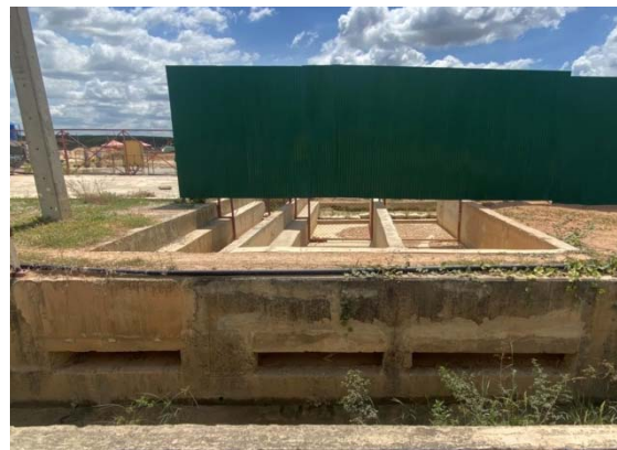
รูปที่ 3-15 จุดระบายน้ำฝนสู่รางระบายน้ำฝน ของสวนอุตสาหกรรม
