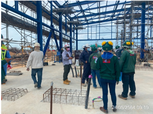
รูปที่ 3-39 การตรวจสอบพื้นที่ก่อสร้าง โดยเจ้าหน้าที่ความปลอดภัยในการทำงาน
