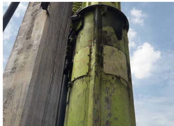
รูปที่ 3-12 การลดเสียงจากการตอกเสาเข็ม
