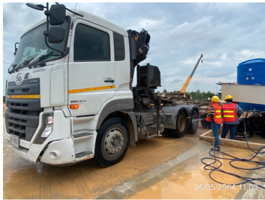
รูปที่ 3-5 การทำความสะอาดล้อรถ ก่อนออกจากพื้นที่โครงการ
