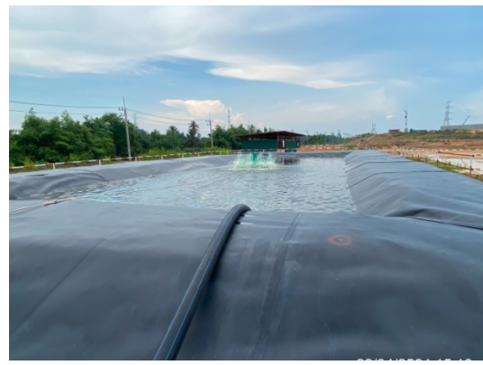
รูปที่ 3-22 บ่อพักน้ำทิ้งสำหรับรองรับน้ำเสีย จากกิจกรรมก่อสร้าง
