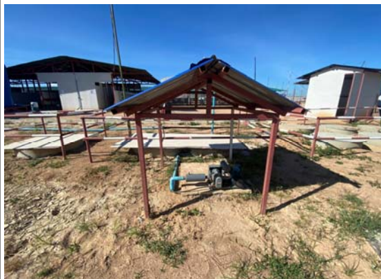
รูปที่ 3-19 ระบบบำบัดน้ำเสียสำเร็จรูป บริเวณพื้นที่โครงการ
