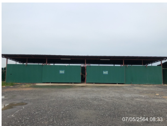
รูปที่ 3-35 พื้นที่รวบรวมกากของเสีย
