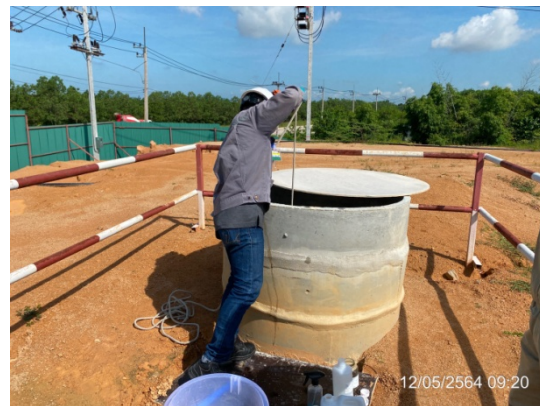
รูปที่ 3-20 บ่อตรวจสอบคุณภาพน้ำทิ้งจากห้องส้วม
