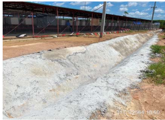
รูปที่ 3-13 รางระบายน้ำภายในพื้นที่โครงการ
