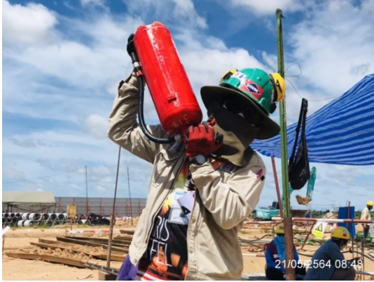
รูปที่ 3-58 การตรวจสอบอุปกรณ์ดับเพลิง
