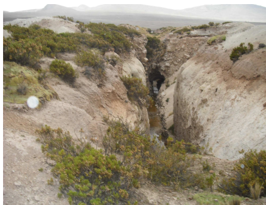
Rajo y túnel
