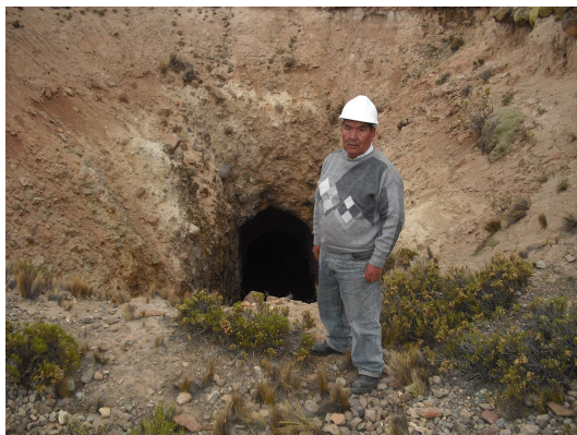
Túnel en mantenimiento
