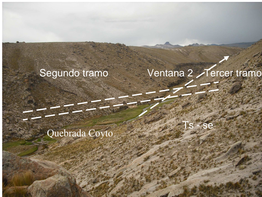
Foto N° 4.2.5-55 Ventana 2, segundo y tercer tramo s del túnel
