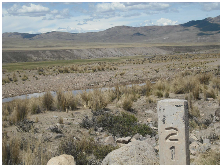
Foto N° 4.2.5-22: Aguas abajo de la anterior vista , muestra erosiones
