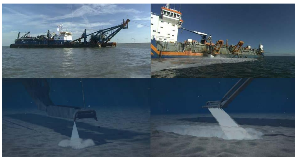
Figuur 4-24: Mass Flow Excavation door dredging pontoon en hopper dredger (NorNed, van Oord)
