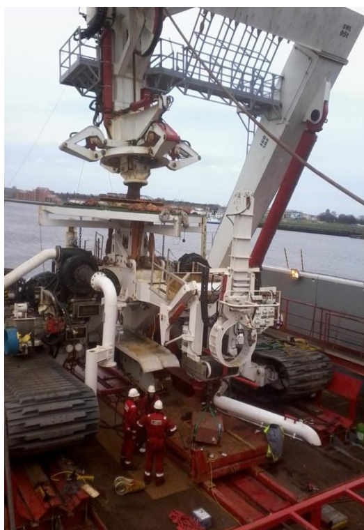
Figuur 4-22: Canyon i - Trencher (mechanical trencher gebruikt bij de aanleg BritNed kabel)
