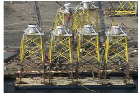
套筒式基座安裝於運輸船作業
