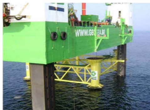
預打基樁作業
