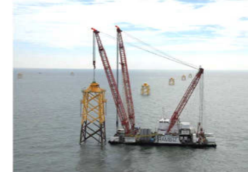
風力機組安裝作業
