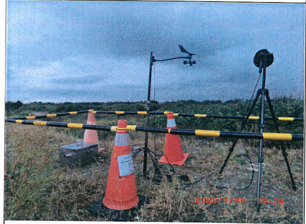
噪音振動：自設降壓站(109.07.27~28)
