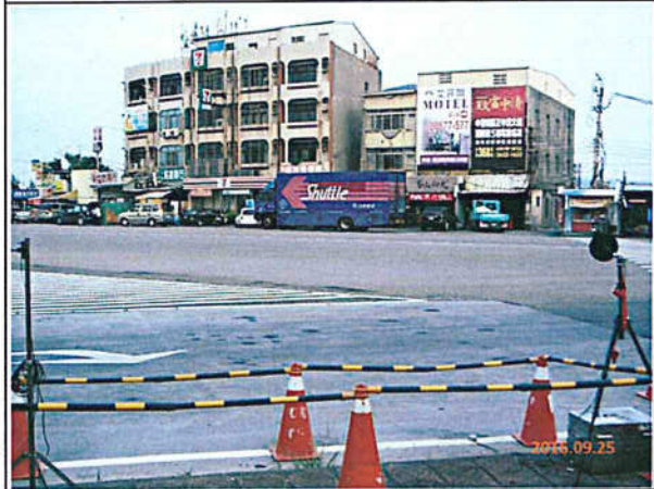
噪音振動：西部濱海公路、北堤路及漁港路路口(105.09.25~26)
