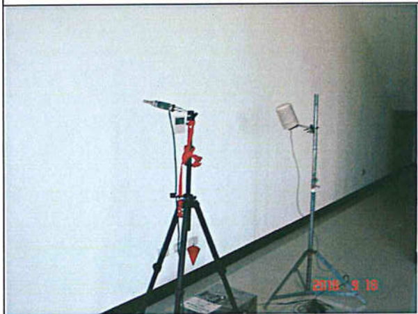
低頻噪音：彰濱超高壓變電所(E/S)(105.09.18~19)
