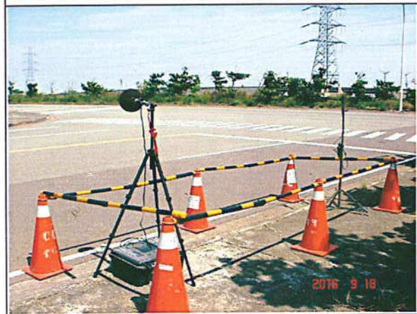
噪音振動：彰濱超高壓變電所(E/S)(105.09.18~19)
