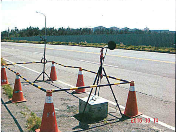
噪音振動：彰濱線西工業區彰濱西二路自設變電站(105.10.14~15)
