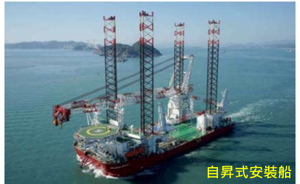
由起重船或自昇式安裝船將套筒式基座安裝到預打基樁上
