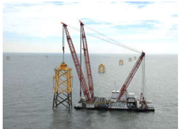
風力機組安裝作業
