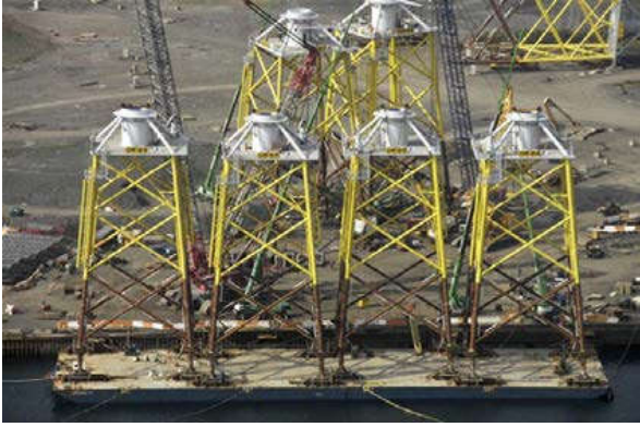
套筒式基座安裝於運輸船作業
