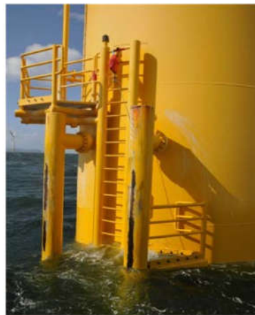
圖 8.2.4-1 離岸風場維護設施示意圖
